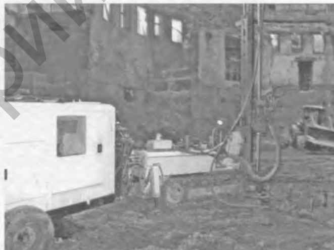
Рис. 3. Устройство противofильтрационной ванны установкой JetGrouting при реконструкции здания цирка
