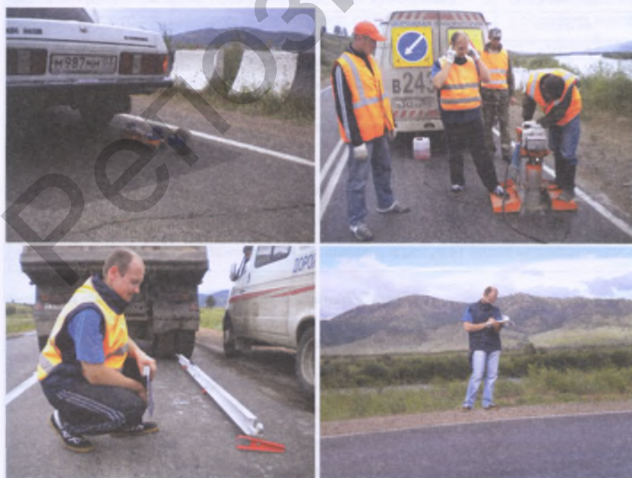
Рис. 11. Выполнение работ по диагностике федеральной дороги М55 "Байкал"
