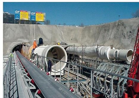
Рисунок 10 – Временная вентиляция
