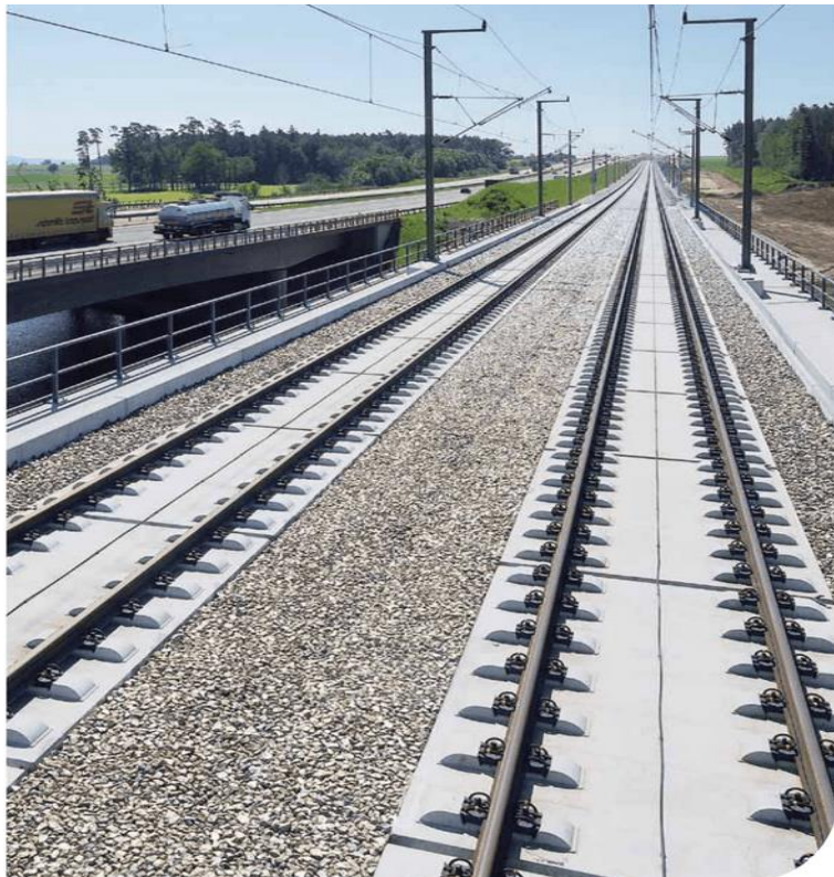
Рисунок 6 – Путь с низким уровнем вибрации LVT
