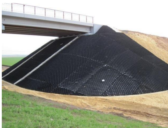
Рисунок 4 – пример укрепленного георешеткой откоса моста
