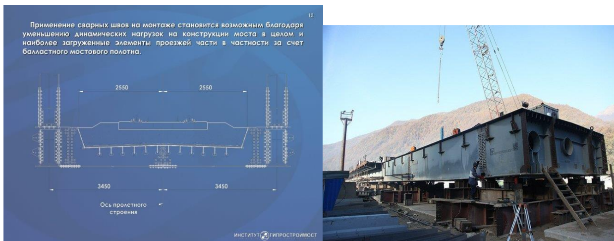
Рисунок 2 – Сварные швы ортотропной плиты
