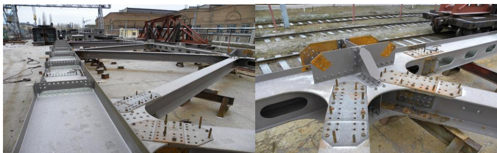
Рисунок 3 – Контрольная сборка части решетки главной фермы
