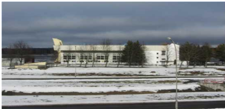
Рис. 2. Поверхностный водозабор на водохранилище Дрозды
