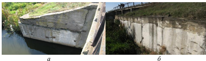
Рис. 2. Правобережная стенка камеры шлюза-регулятора:
