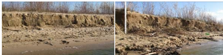
Рис. 3. Створы № 1 и № 2 на Краснослободском водохранилище
