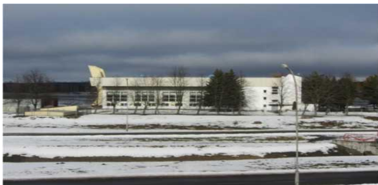
Рис. 2. Поверхностный водозабор на водохранилище Дрозды
