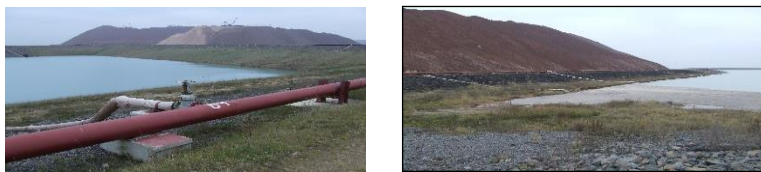
Рис. 1. Ограждающие сооружения шламохранилищ Солигорского калийного комбината
