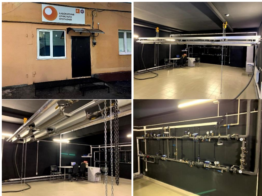
Рис. 1. Общий вид Лаборатории лучистого отопления
