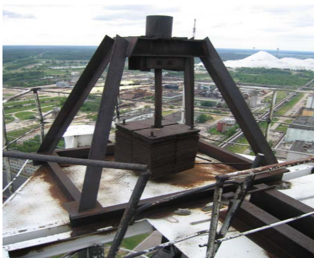
Рис.1. Динамический гаситель колебаний (фотография, не относящаяся к объекту)
