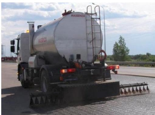
Рис. 1. Нанесение ГПС
