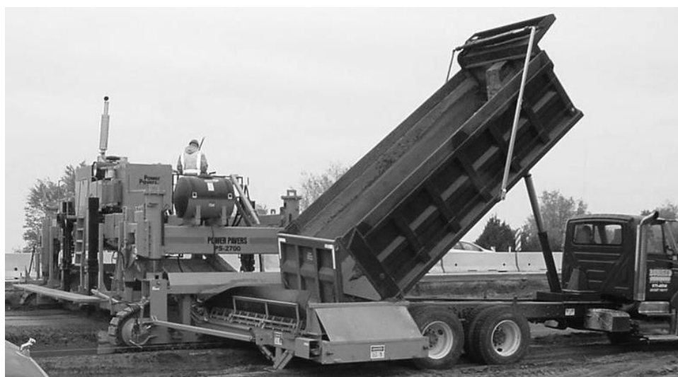
Рисунок 2 – Бетонораспределитель POWER PAVERS PS-2700
