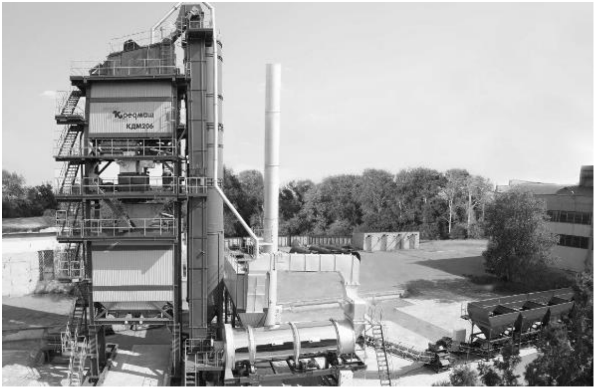
Рисунок 1 – Асфальтобетонный завод (АБЗ)
