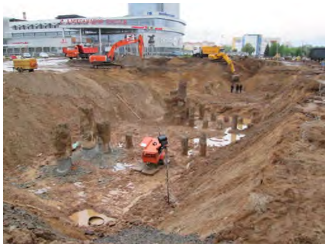
Рис. 4. Общий вид разработки котлована
