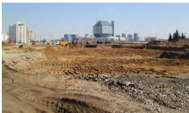
Рис. 1. Общий вид строительной площадки до начала строительства
