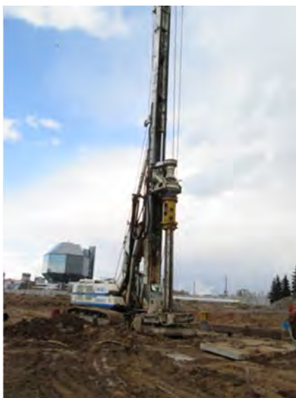
Рис. 2. Бурение скважины под набивную сваю защитного экрана
