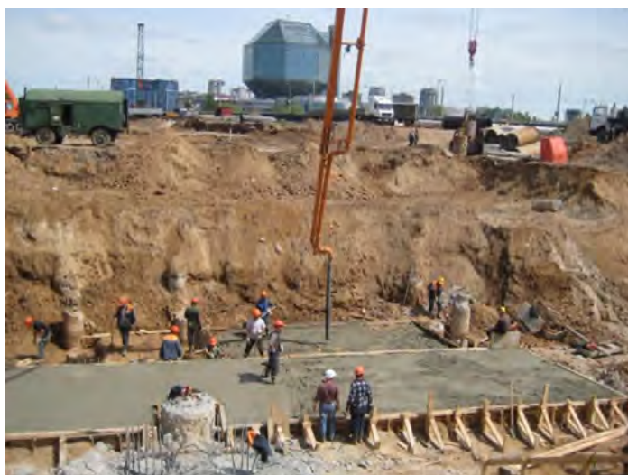
Рис. 5. Бетонирование плиты защитного экрана и подготовки под плиту
