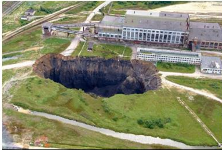
Рис.17. Провал грунта на территории завода «Уралкалий»
