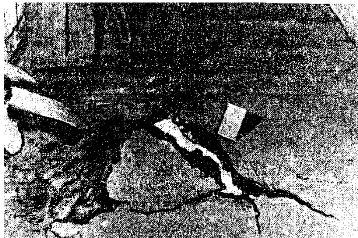
Рис. 13. Разрушение асфальтового покрытия растущими грибами
