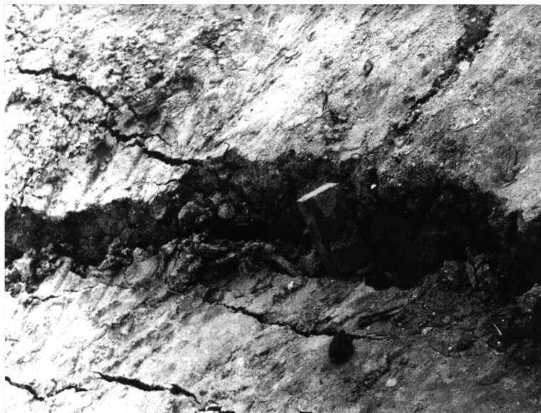
Рис. 40. Оползневые трещины на поверхности грунта
