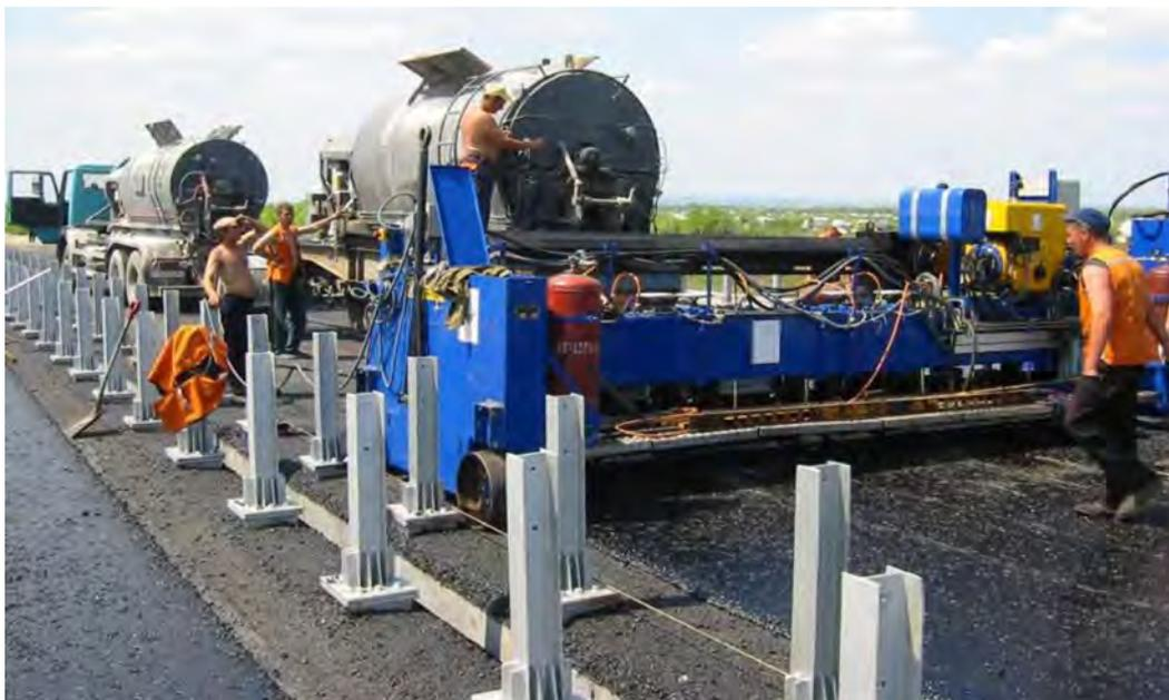
Рисунок 2 - Устройство дорожного покрытия из литого асфальтобетона
