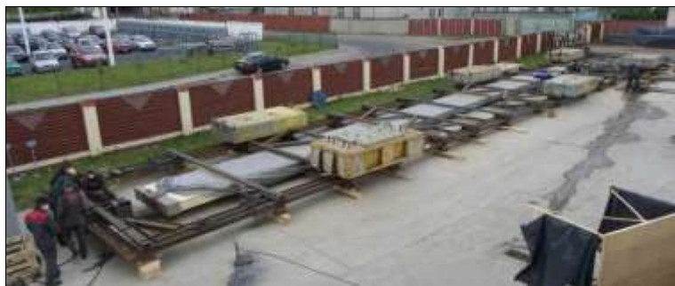
Рис. 12. Общий вид испытательной установки в процессе монтажа
