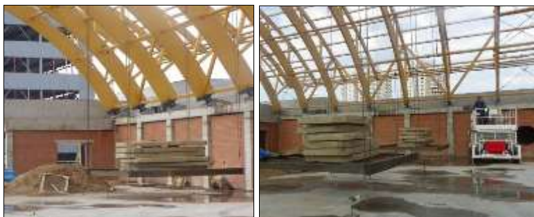
Рис. 10. Фрагменты испытания нагружением деревянных арок покрытия в составе покрытия
