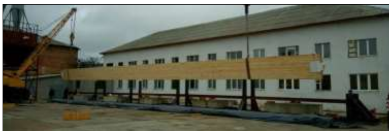
Рис. 6. Монтаж деревянной балки в испытательный стенд
