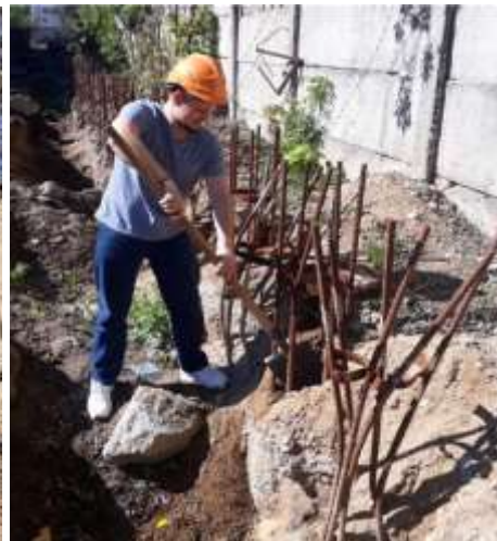
Рис. 3. Процесс очистки поверхности сваи
