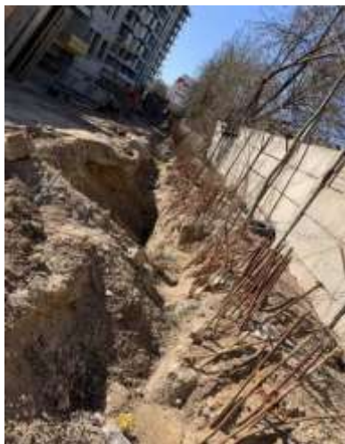
Рис. 3. Процесс очистки поверхности сваи
