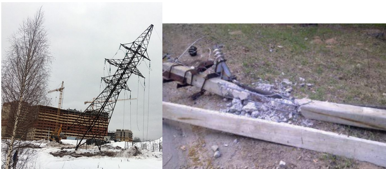
Рисунок 2 – Демонтаж линий электропередач 110 кВ и 35 кВ
