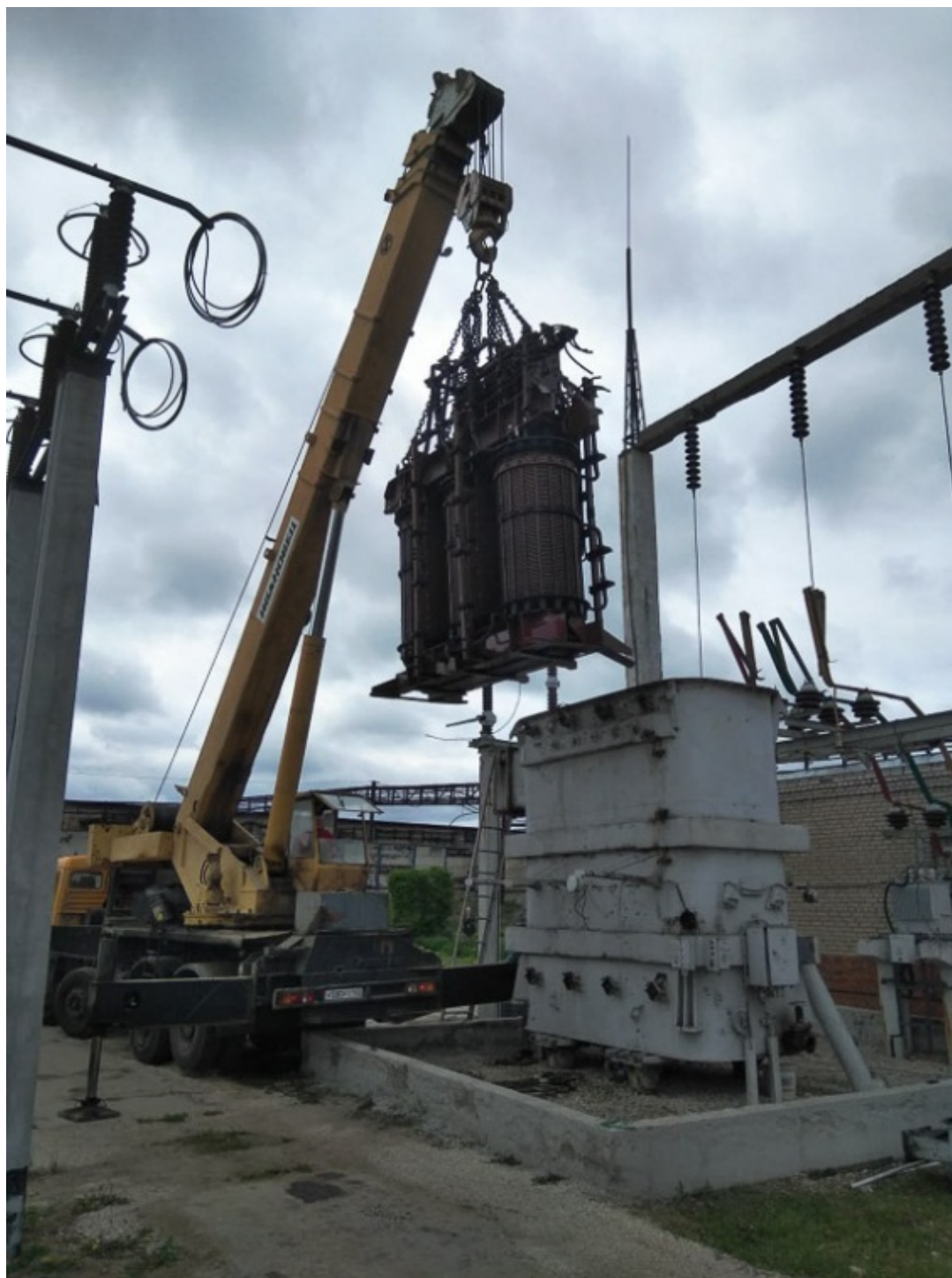
Рисунок 1 – Демонтаж трансформатора 115/10.5 кВ
