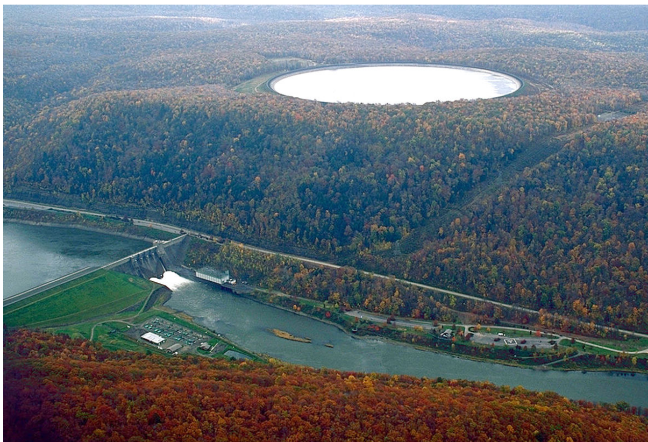
Рисунок 1 – Верхний резервуар с водой.
