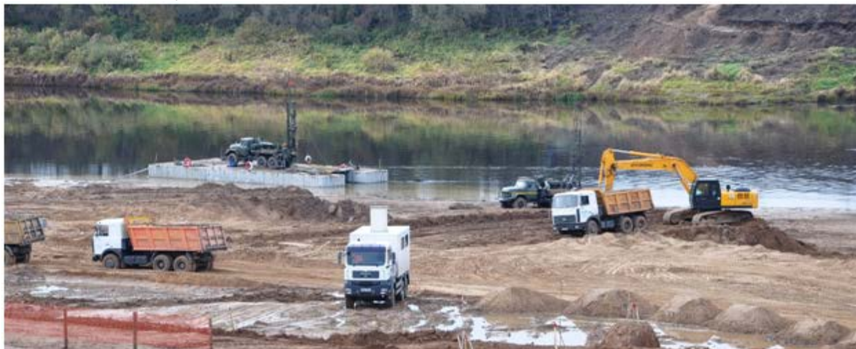
Рисунок 3 – Строительство Полоцкой ГЭС.
