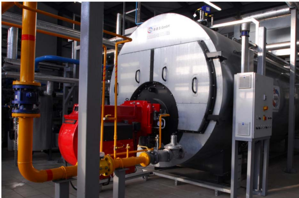
Рисунок 1 – Паровой котёл BBS GmbH HDK 8.000
