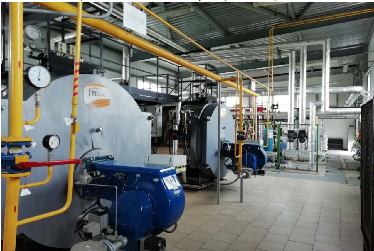
Рисунок 2 – Паровые котлы VAPOPREX HVP 5000/12
