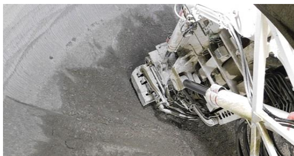
Рис."4 – Забой шахтного ствола при проходке СБР
