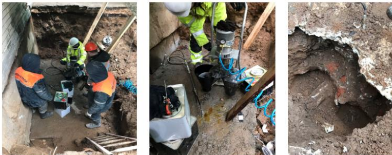
Рис. 1. Этапы выполнения работ
