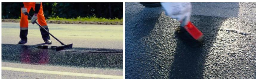
Рис. 3. Распределение ГПС вручную
