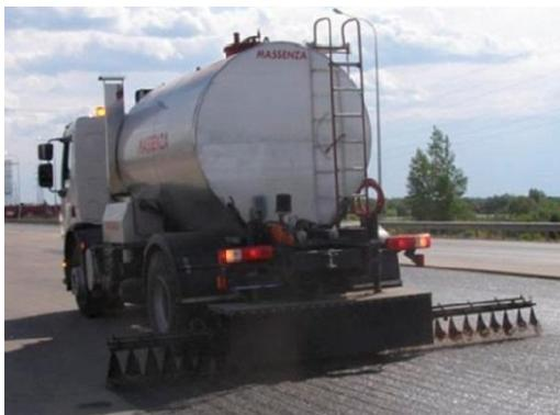
Рис. 1. Нанесение ГПС с низкой вязкостью с помощью автогудронатора
