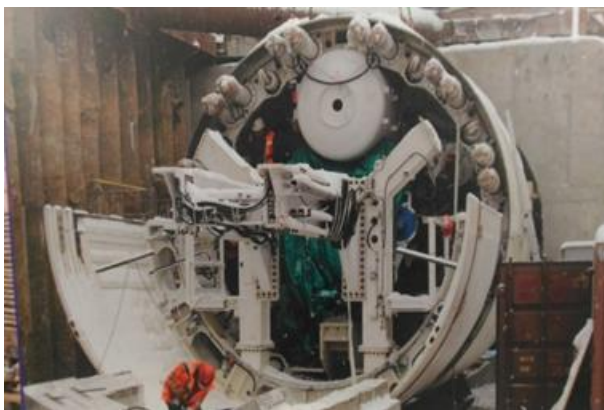
Рис. 1. смонтированный ТПМК «Алеся» на ложе
