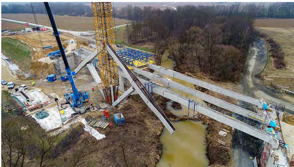
Рисунок 1 – Опускание балок гидравлической системы
