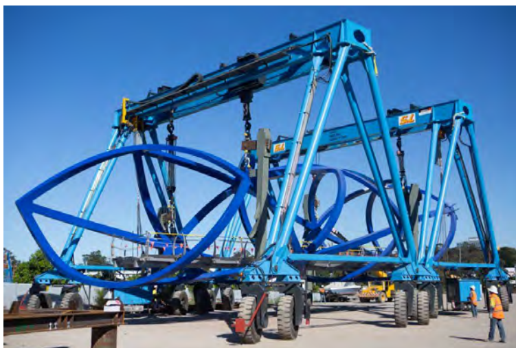
Рисунок 2 – Перемещение секции на площадку
