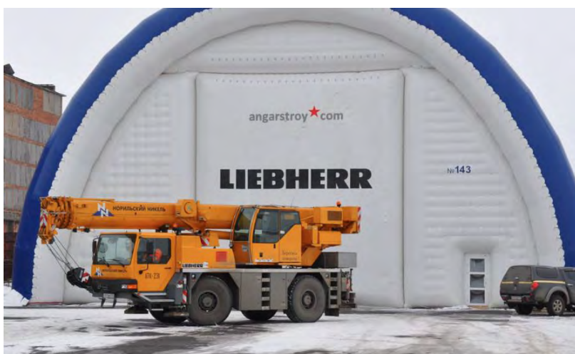
Рисунок 3 – Применение пневмокаркасного сооружения в качестве гаража для техники «Liebherr» г. Дудинка Красноярский край [3]
