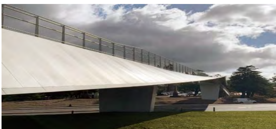
Рисунок 5 – Крылья моста опущены
