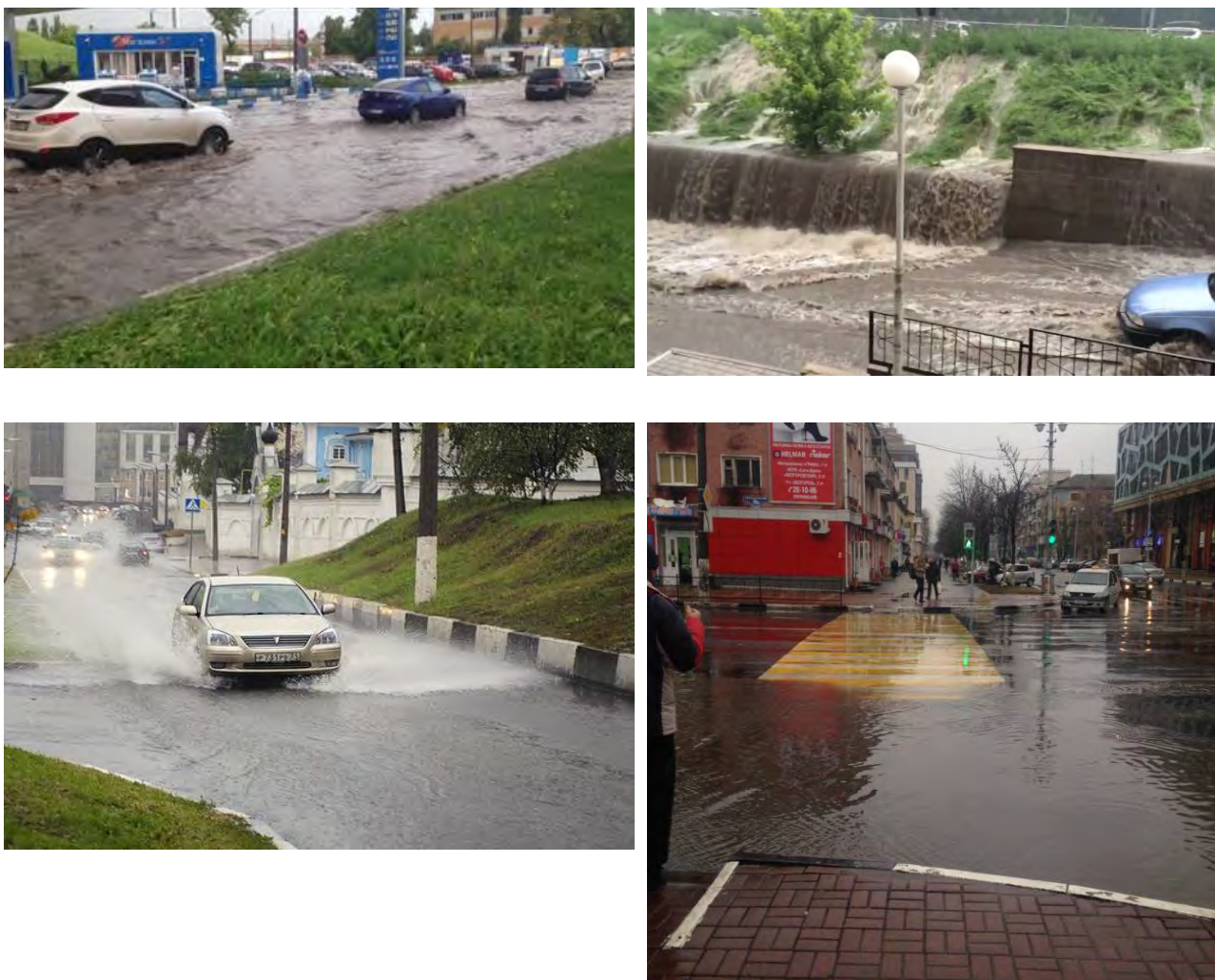
Рисунок 2 – Несоответствие существующей сети ливневой канализации требуемым нормам
