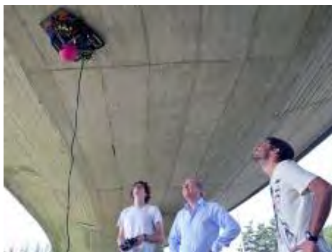
Рисунок 2 – C2D2 взбирается на стены и потолки для обнаружения коррозии
