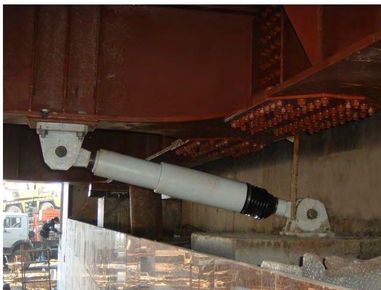
Рисунок 11 – Стальной гидравлический демпфер RESTON®SA
