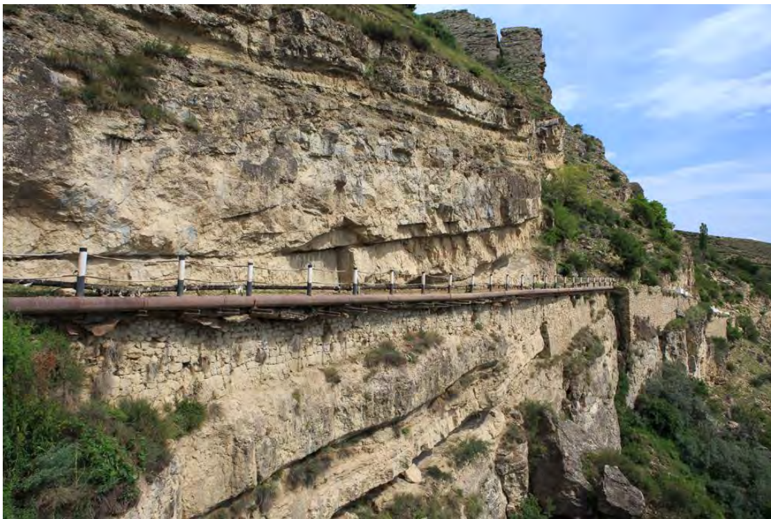
Рисунок 8 – Вид балкона с металлическими консолями, заделанными в скалу Источник: http://kirill-anya.ru/2015/caucasus/05.html
