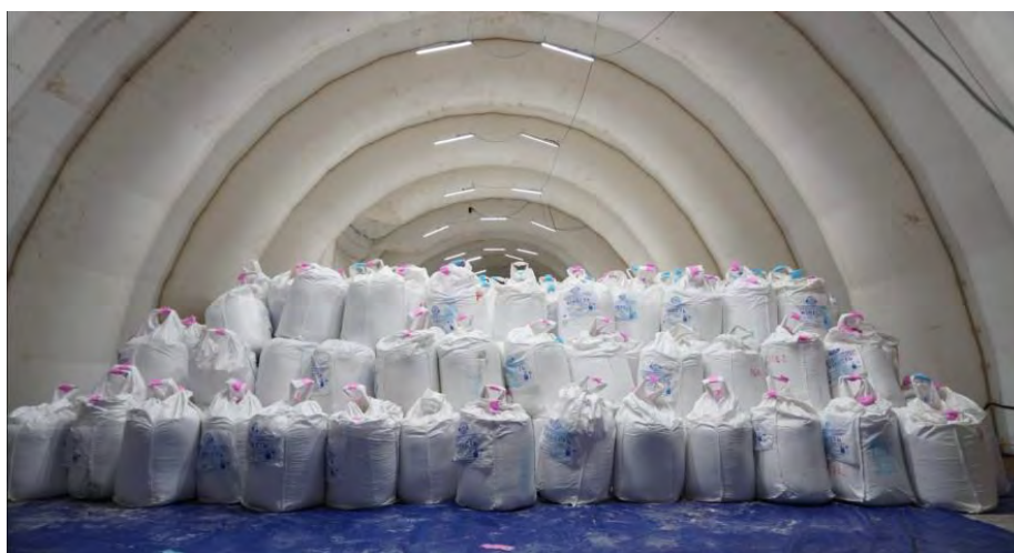
Рисунок 4 – Применение пневмокаркасного сооружения в качестве склада инертных материалов «Норильский никель» г. Дудинка Красноярский край [4]
