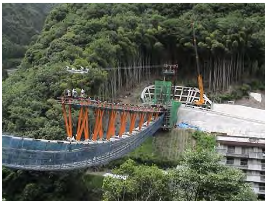
Рисунок 1 – Возведение моста с композитной подвесной конструкцией
