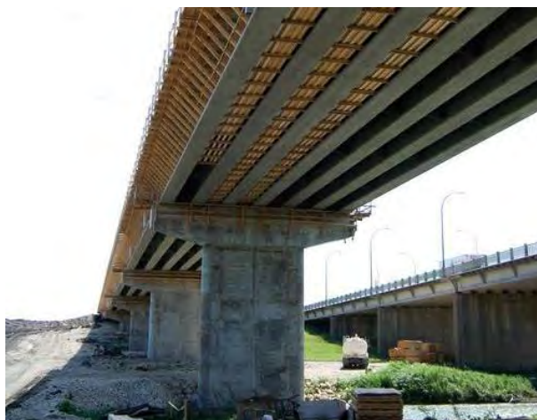
Рисунок 2 – Строительство моста через реку Red River Floodway
