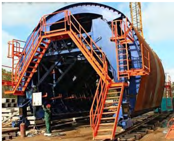
Рисунок 2 – Катучая тоннельная опалубка ПСК
