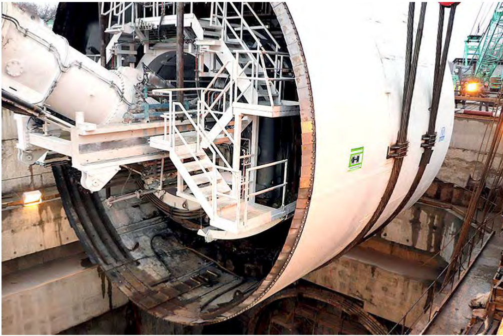
Рисунок 8 – Тоннелепроходческий комплекс «Виктория»
