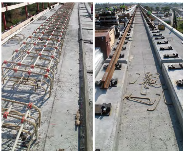
Рисунок 3 – Miami-Dade MetroRail, стеклопластиковая арматура перед укладкой бетона и готовое полотно
