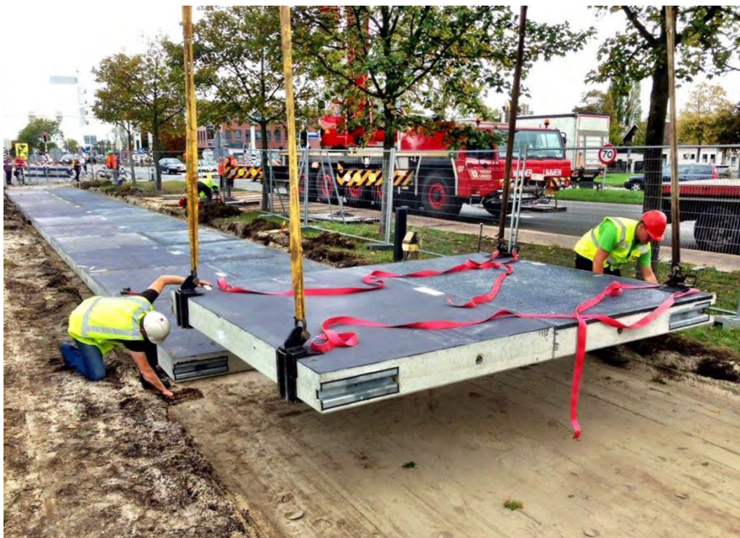
Рисунок 4 – Установка модулей SolaRoad
