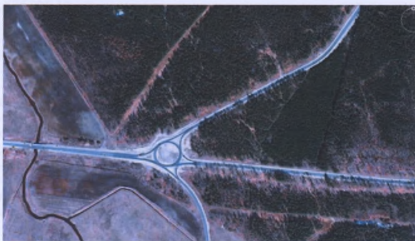
Рисунок 1 – Круговая развязка на автомобильной дороге М-5 Минск – Гомель (реконструируется) на подходе к г. Бобруйску
