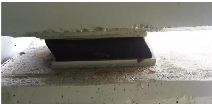
Рис. 2. Резинометаллическая опорная часть в составе эксплуатируемого сооружения
