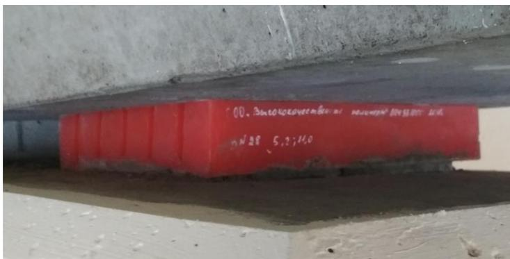
Рис. 3. Полиуретановая опорная часть в составе эксплуатируемого сооружения
