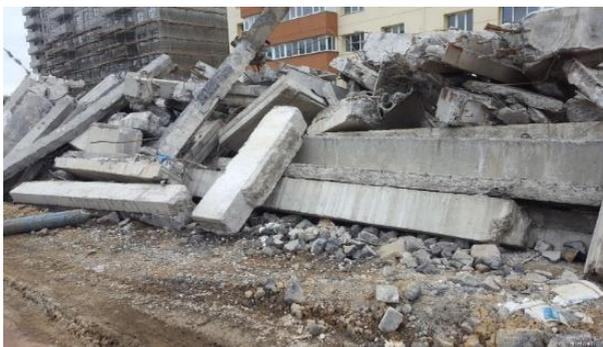
Рис. 1. Отходы бетона и железобетона
