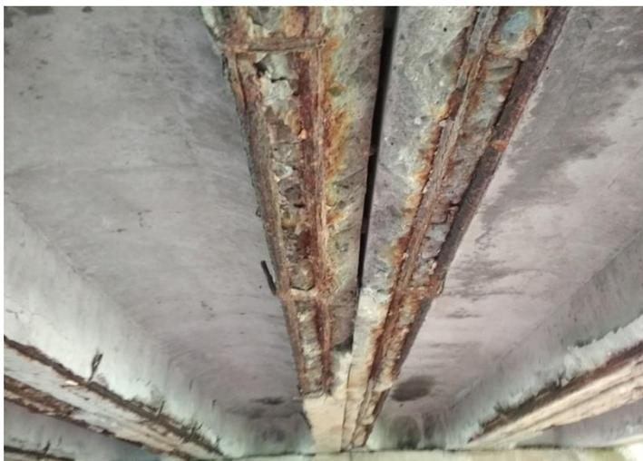
Рис. 1. Разрушение бетона и коррозия арматуры ребристой плиты пролетного строения
