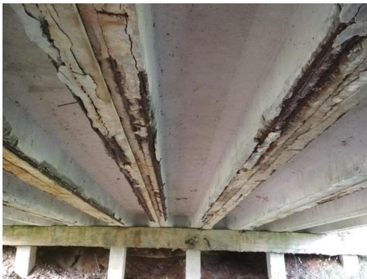
Рис. 1. Разрушение бетона и коррозия арматуры
