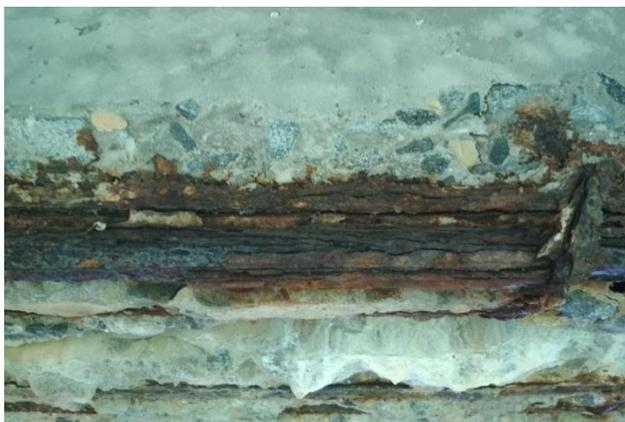
Рис. 2. Пластовая коррозия арматуры ребристой плиты пролетного строения
