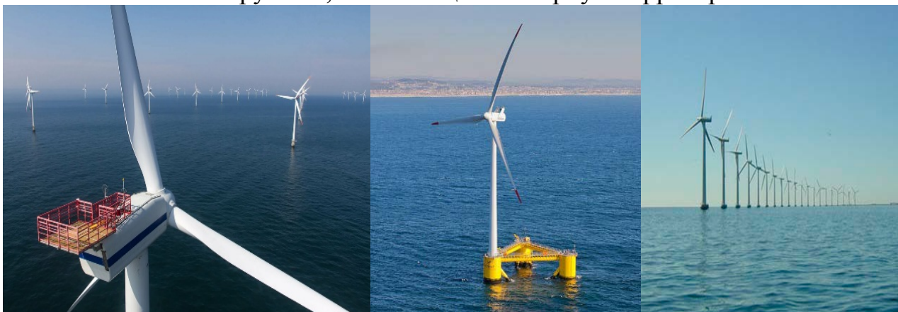
Рисунок 1 – слева направо: офшорные, плавающие и шельфовые ВЭС
