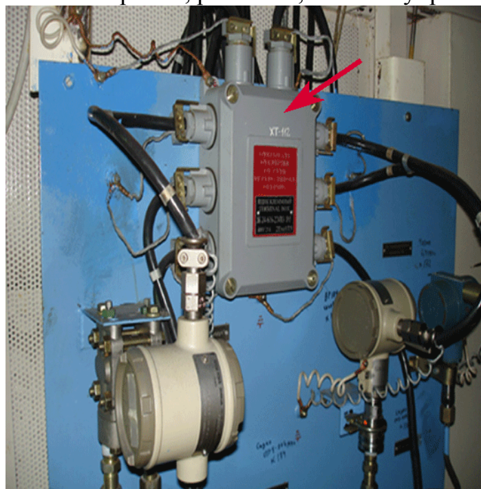
Рисунок 1 – Клеммный ящик
