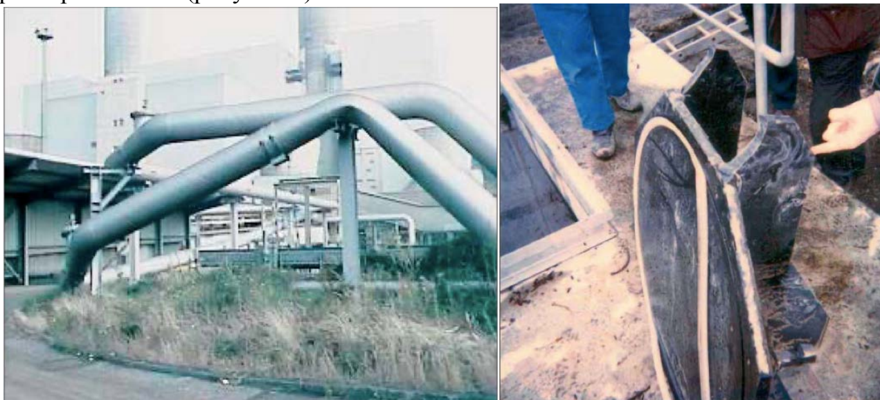
Рисунок 3 – Последствия гидроударов
