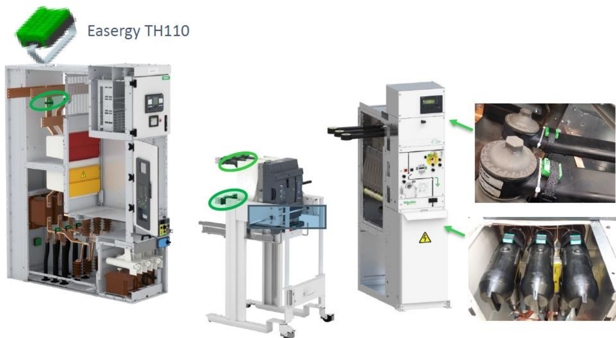
Рисунок 2 – Места установки термодатчика TH110
