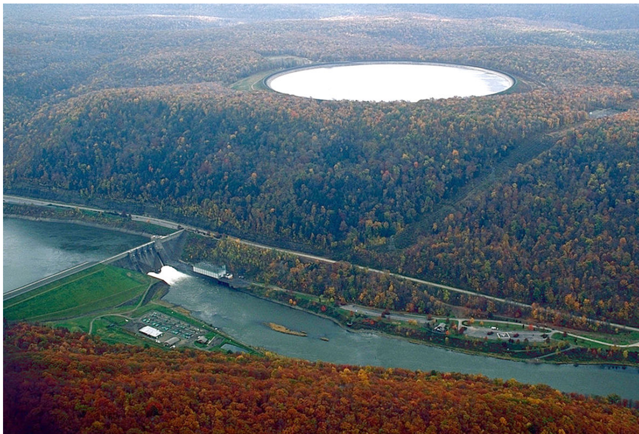
Рисунок 1 – Верхний резервуар с водой.
