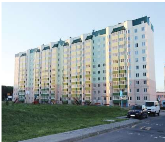
Рис. 3. Энергоэффективный жилой дом второго поколения в г. Могилеве
