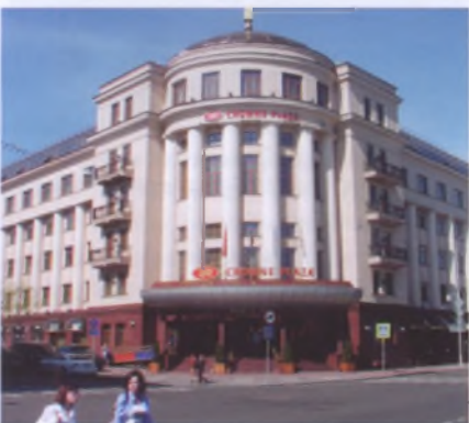
Здание гостиницы Беларусь, 1934–1938 гг. (после реконструкции гостиница Crown Plaza). Архит. А. Воинов (в соавт.)
