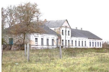
Рис.2 Фрагмент главного здания усадьбы в деревне Туча
