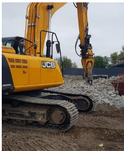
Рис. 2. Экскаватор с навесным оборудованием (бетонолом)
