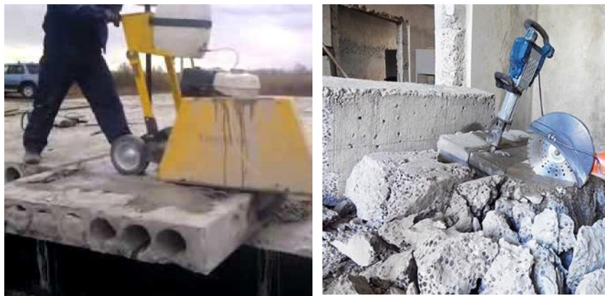
Рис. 3. Резка железобетона вручную, при помощи бензореза и разрушение отбойным молотом
