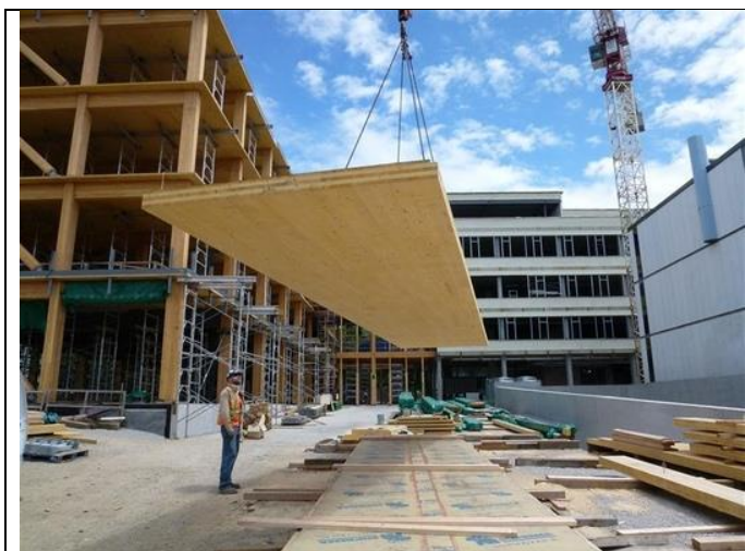
Рисунок 3 - Возведения многоэтажных зданий с применением деревянных панелей CLT и клееного бруса LVL
