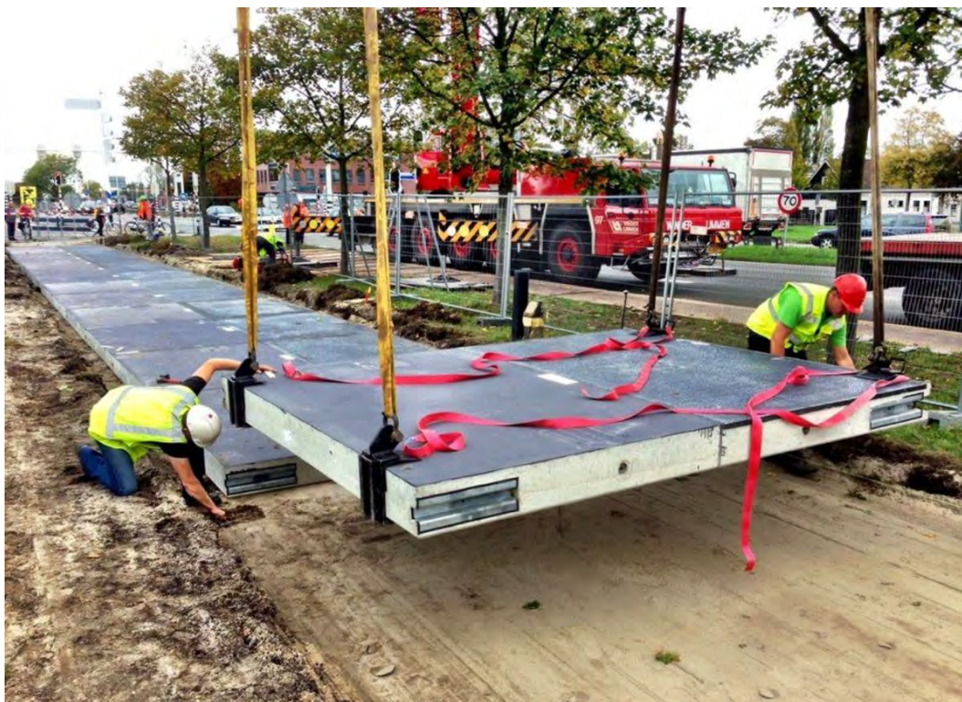
Рисунок 4 – Установка модулей SolaRoad
