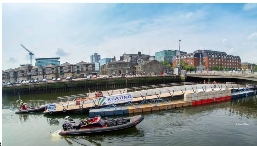
Рисунок 3 – Транспортировка моста
