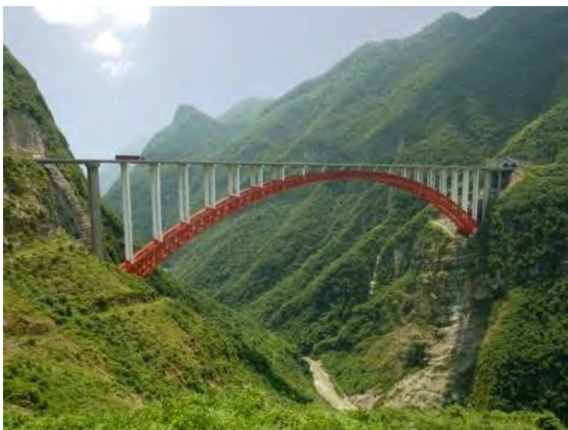
Рисунок 5 – Арочный мост Чжинцзинхэ пролетом 430 м с трубобетонными арками Источник: http://10mosttoday.com/10-highest-bridges-in-the-world/
