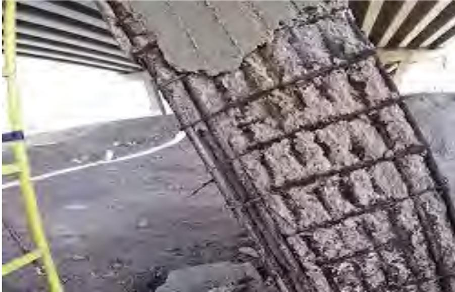
Рисунок 1 – Коррозионные повреждения бетонной опоры моста
