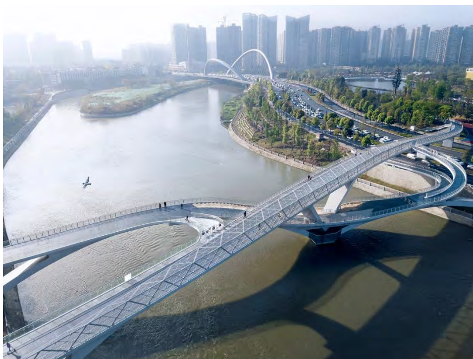
Рисунок 1 – Общий вид моста днём
