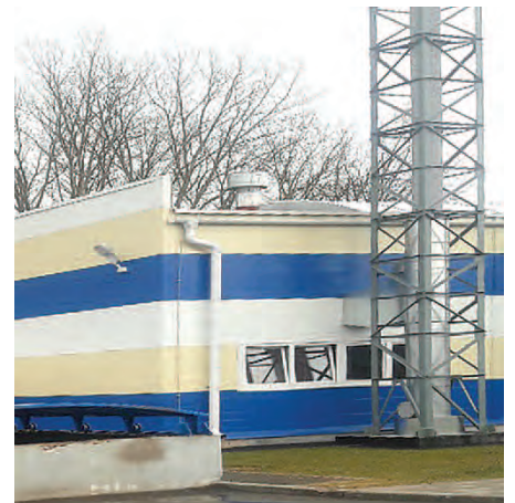
Рис. 8. Котельная, приспособленная для сжигания дробленки
