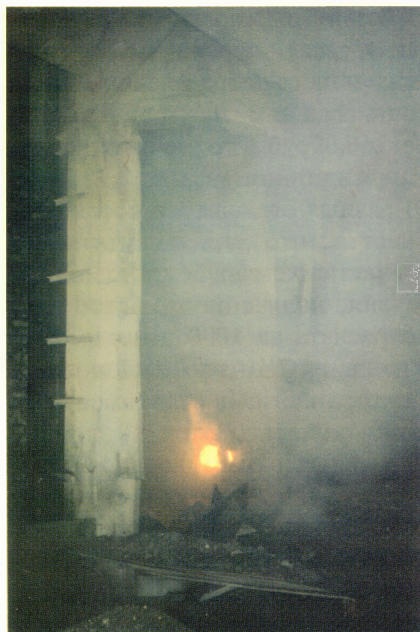
Фото 2. Завалочное окно на 20-тонной вагранке в ЛЦСЧ до модернизации печи
