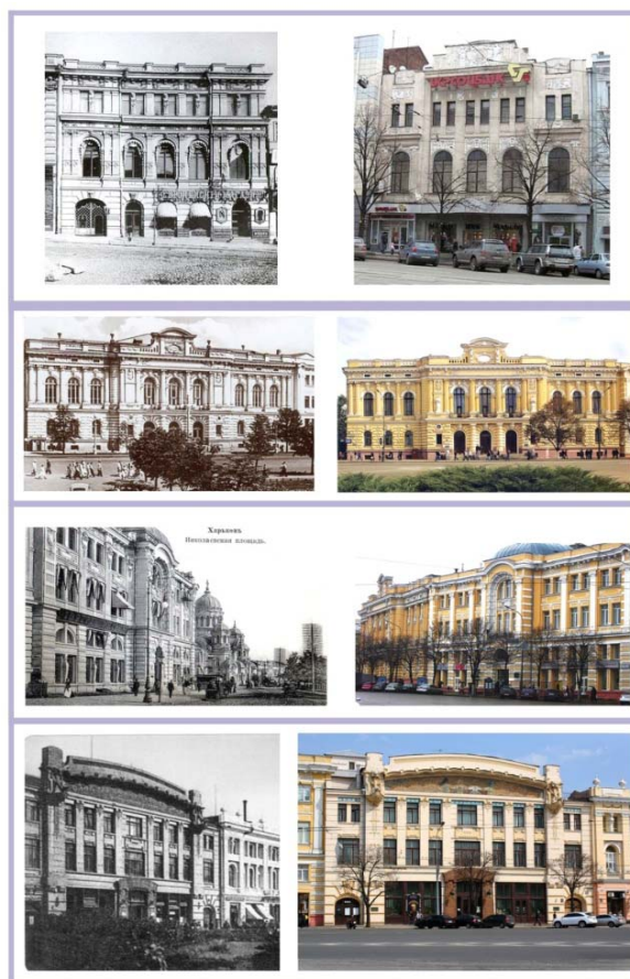
Рис. 3. Здания банков на Николаевской площади (ныне пл. Конституции) в Харькове. Фотофиксация к. XIX – нач. XX в. / нач. XXI в.
