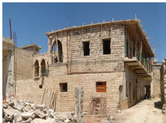
Рис. 1. Реставрация жилого дома в г. Бент Жбейль
