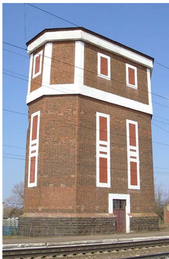
Рис. 5. Водонапорная башня в д. Приямино
