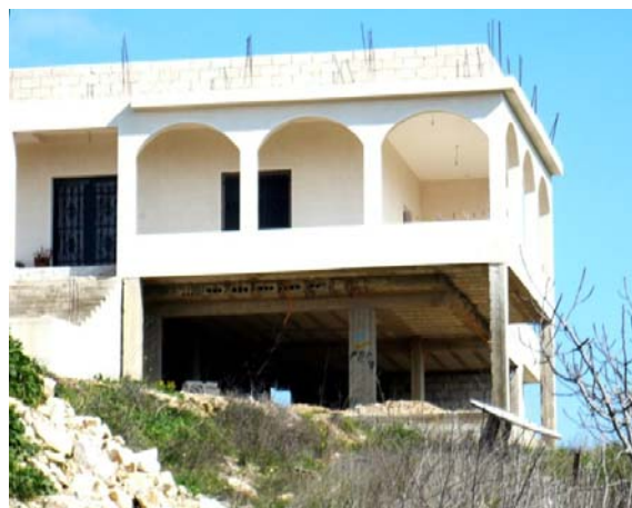
Рис. 3. Галерея в новом жилом доме в г. Айната
