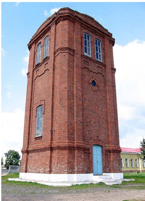
Рис. 4. Водонапорная башня в г. Старые Дороги
