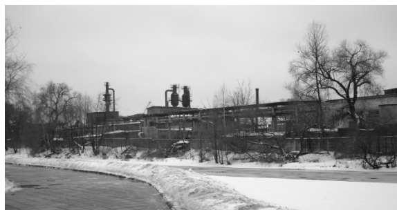
Рис. 4. Вид на застройку завода им. Кирова в Минске (фото автора)
