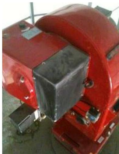
Рис. 2. Горелка фирмы WEISHAUPТ/G50/2-A
