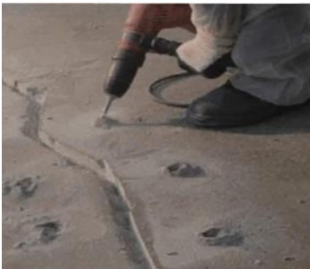
Рисунок 3. - Бурение отверстий для установки иньекторов
