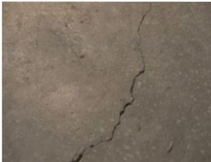
Рисунок 1. - Подвижная трещина. Общий вид
