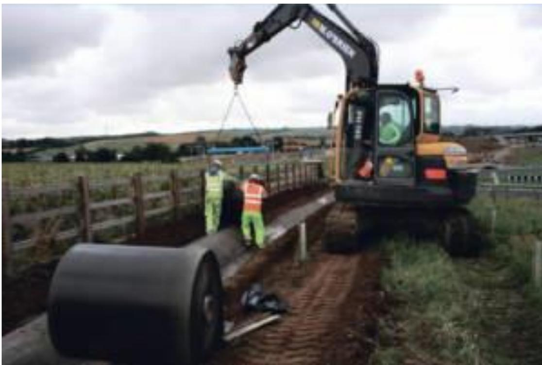
Рисунок 4.6. - Бетонное полотно Concrete Canvas
