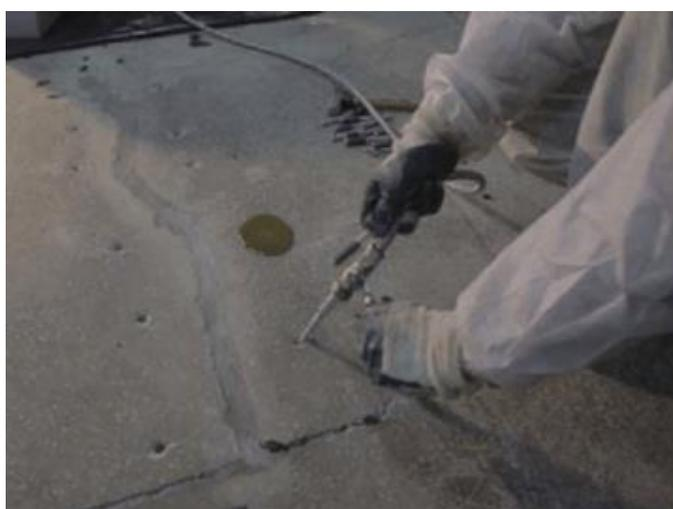
Рисунок 4. - Выполнение иньекционных работ
