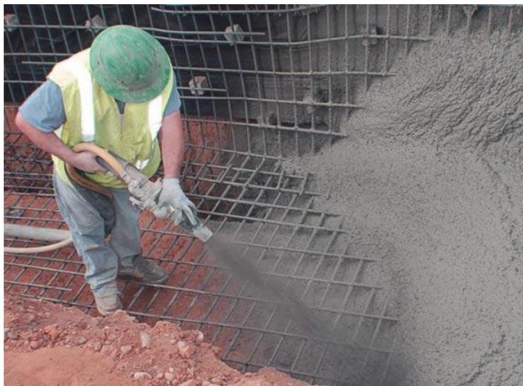
Для выполнения работы класс торкрет-бетона принимается на один выше, чем у бетона усиливаемой конструкции, но не ниже В15. Цементно-песчаная смесь готовится в соотношении от 1:3 до 1:5. Цемента марки не ниже 400 до 600 кг/м<sup>3</sup>. Фактическое В/Ц отношение на выходе из сопла от 0,3 до 0,4.
