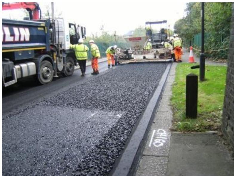
Рисунок 8.1. – Укладка пористого дорожного покрытия
