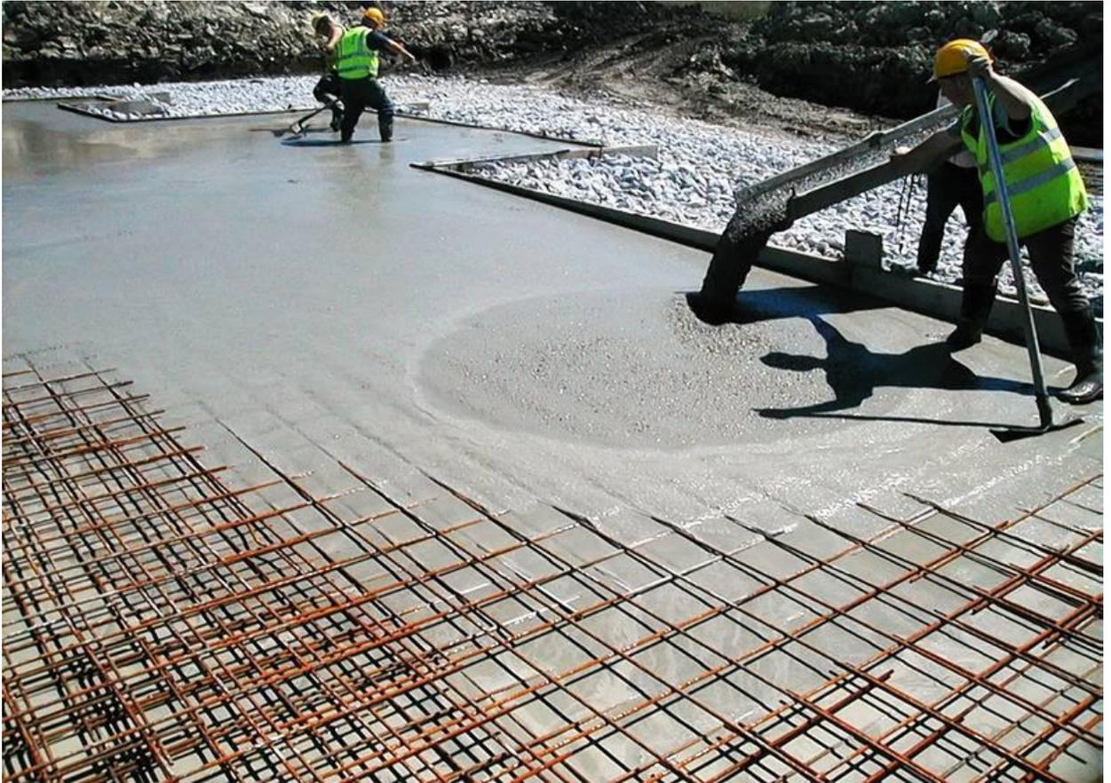
Рисунок 4.1. – Укладка самоуплотняющегося бетона
