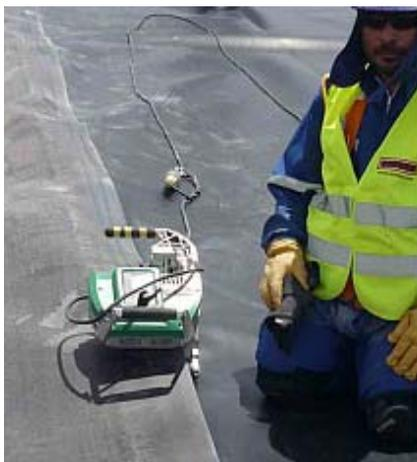
Рис. 8А. Автоматический аппарат горячего клина «Geostar G7» сваривает со скоростью до 12 м/мин
