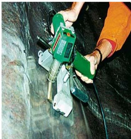
Рис. 7А. Сварочный автомат горячего воздуха «Twinny S» с коротким комбинированным клином при сварке гидроизоляции в тоннеле со скоростью до 4 м/мин
