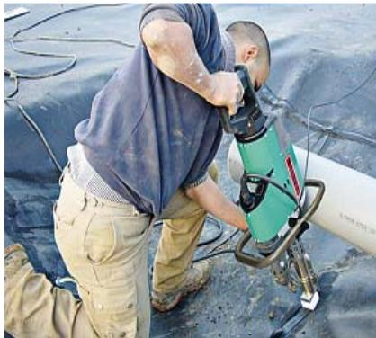
Рис. 9А. Ручной сварочный экструдер «Weldplast S6» при сварке сложного шва на полигоне
