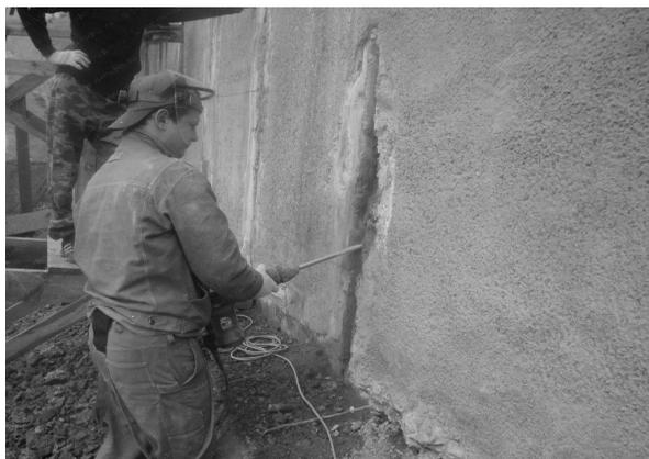
Рис. 2. Ремонтные работы для гидроизоляции шва с протечкой
