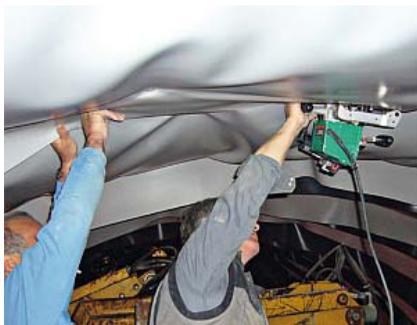
Рис. 4А. Сварочный аппарат горячего воздуха «Twinny T» идеальная сварка на любой поверхности
