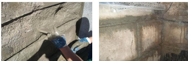
Рис. 4. Огрунтовка поверхности и заделка штраб, стыков
