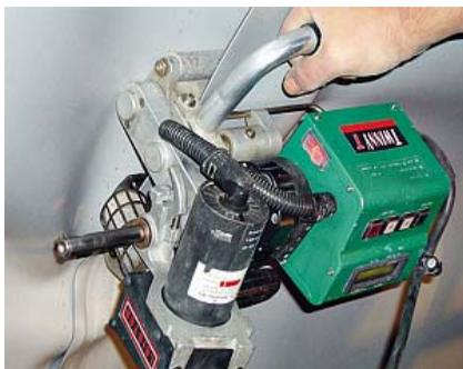
Рис. 6А. Сварочный аппарат горячего воздуха «Twinny T» при сварке гидроизоляции в туннеле
