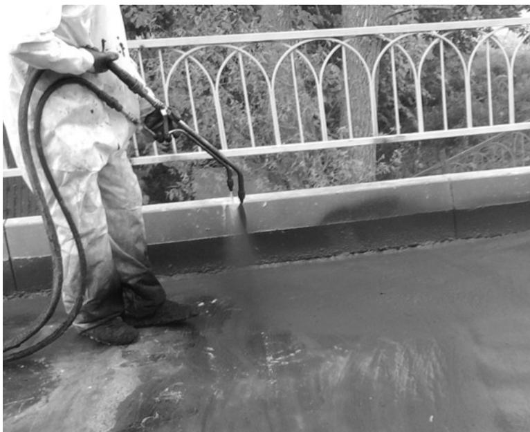
Рис. 7. Гидроизоляция моста материалом Dorflex®
