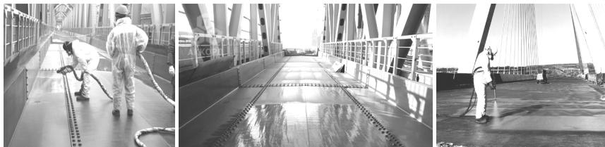
Рис. 19. Гидроизоляция и антикоррозионная защита полимочевинной мостов и путепроводов
