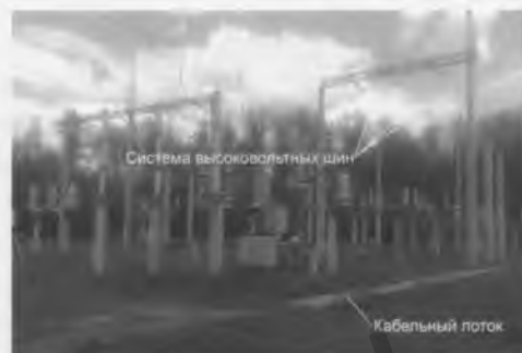
Рис. 9. Прокладка кабелей вторичных цепей вдоль высоковольтных шин
