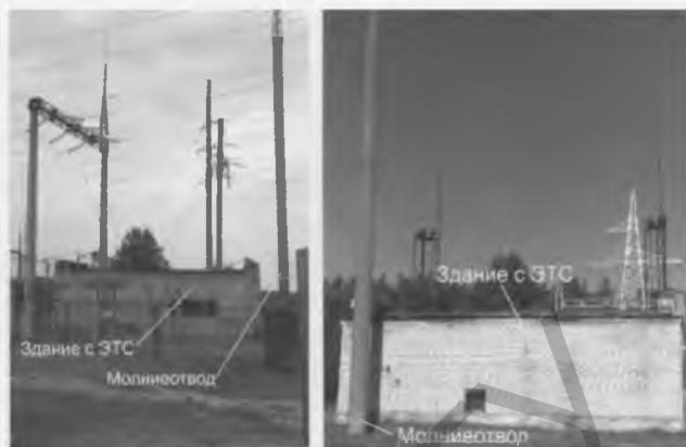
Рис. 5. Примеры несоблюдения допустимых расстояний от молниеотводов до мест установки ЭТС (молниеотвод установлен непосредственно у здания с ЭТС)
