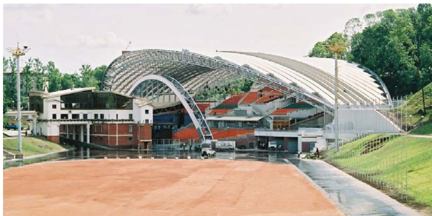
Рисунок 21 – Общий вид покрытия Летнего амфитеатра
