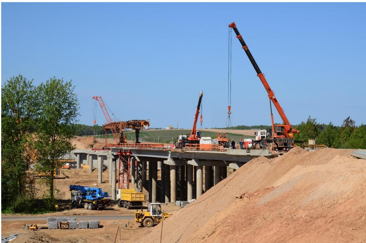
Рисунок. Расположение кранов при монтаже пролетных строений
