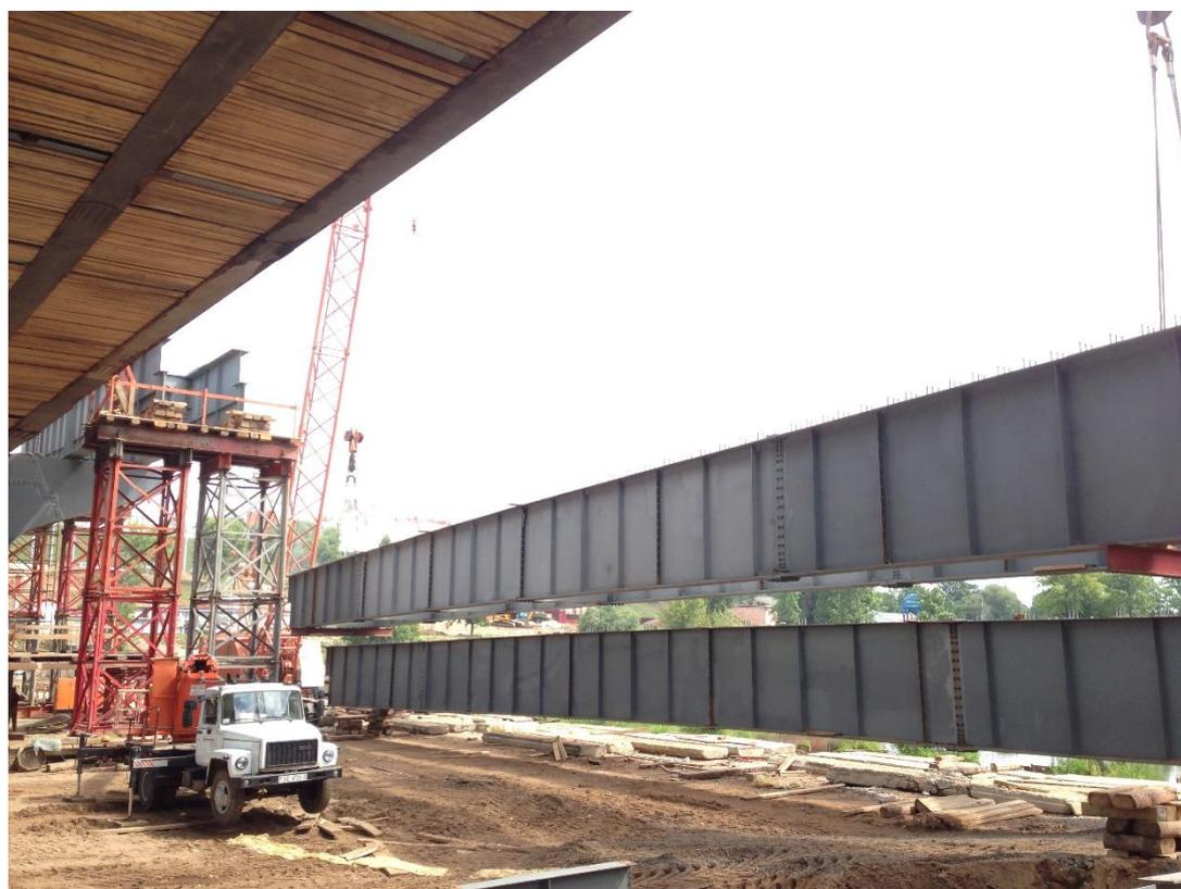
Рисунок 2 – Временная опора из инвентарных конструкций
