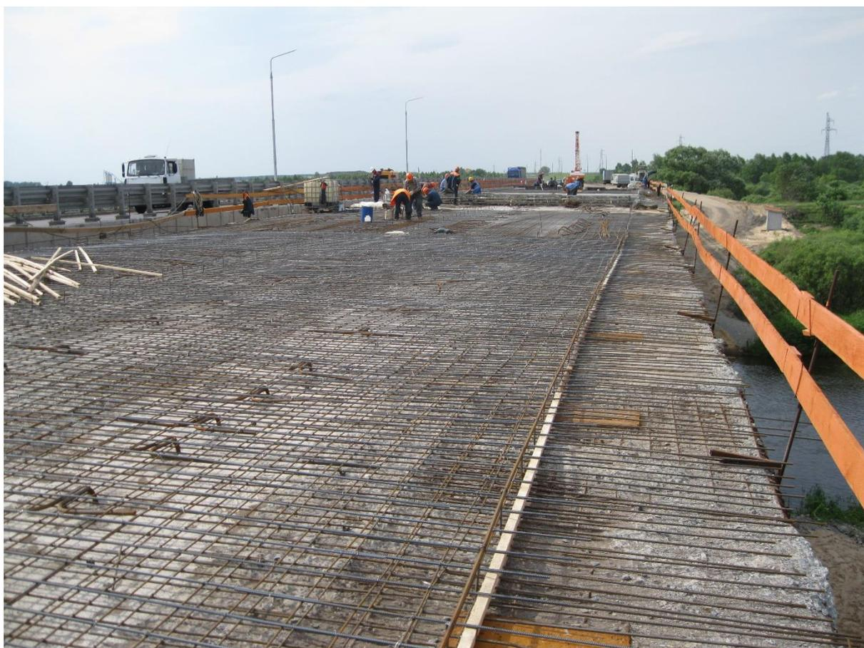
Рисунок. Ограждение рабочей зоны на пролетном строении
