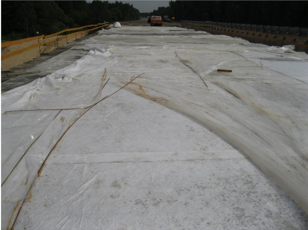
Рисунок. Защитная пленка на пролетном строении
