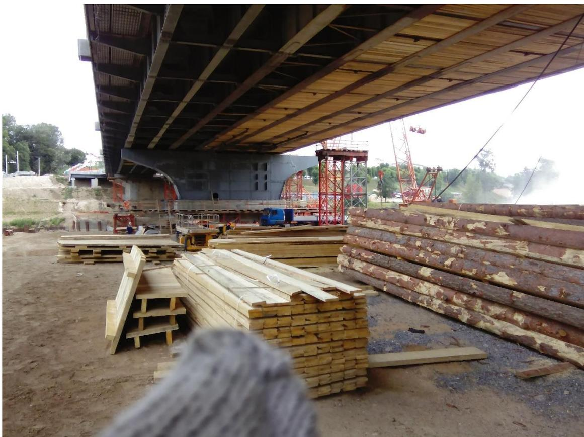
Рисунок. Складирование пиломатериалов на строительной площадке
