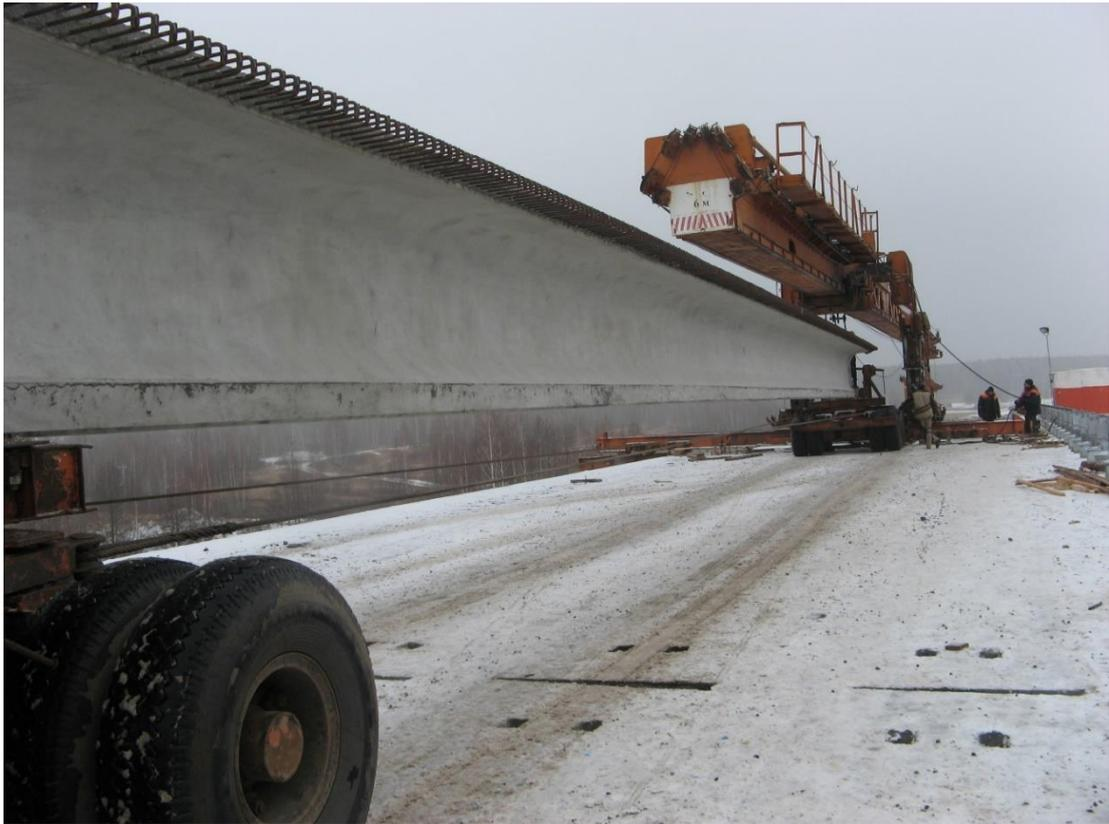
Рисунок. Подача балки монтируемого пролетного строения со смонтированным пролетным строением
