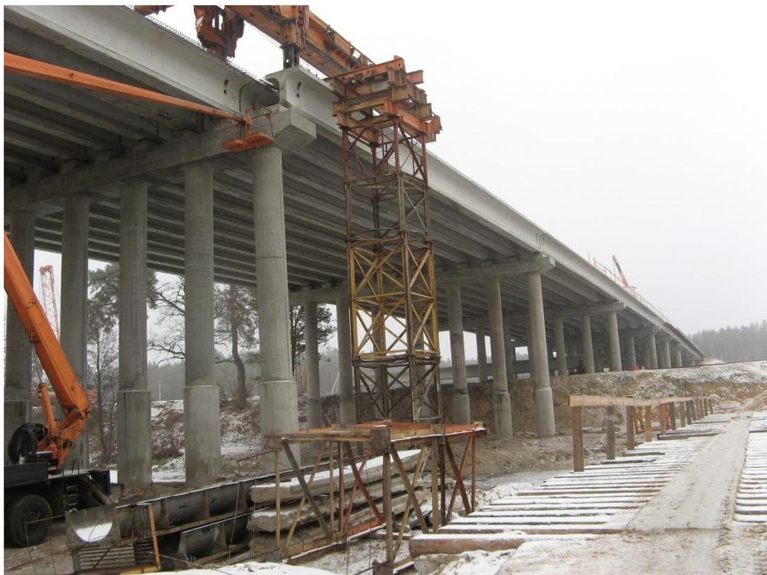
Рисунок 1 – Временная опора для крана КШМ из инвентарных конструкций
