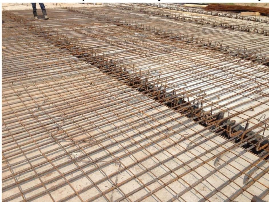
Рисунок. Устройство накладной плиты
