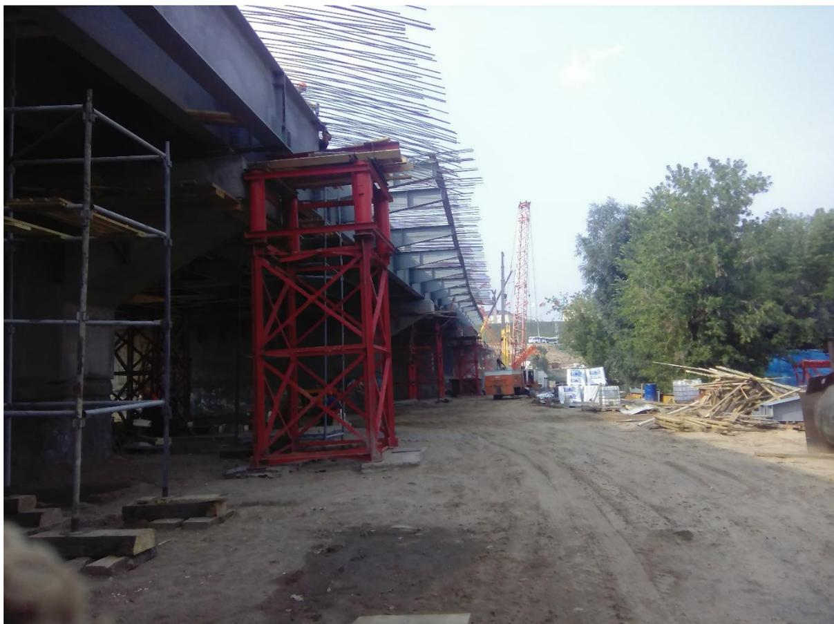
Рисунок. Сталежелезобетонное пролетное строение
