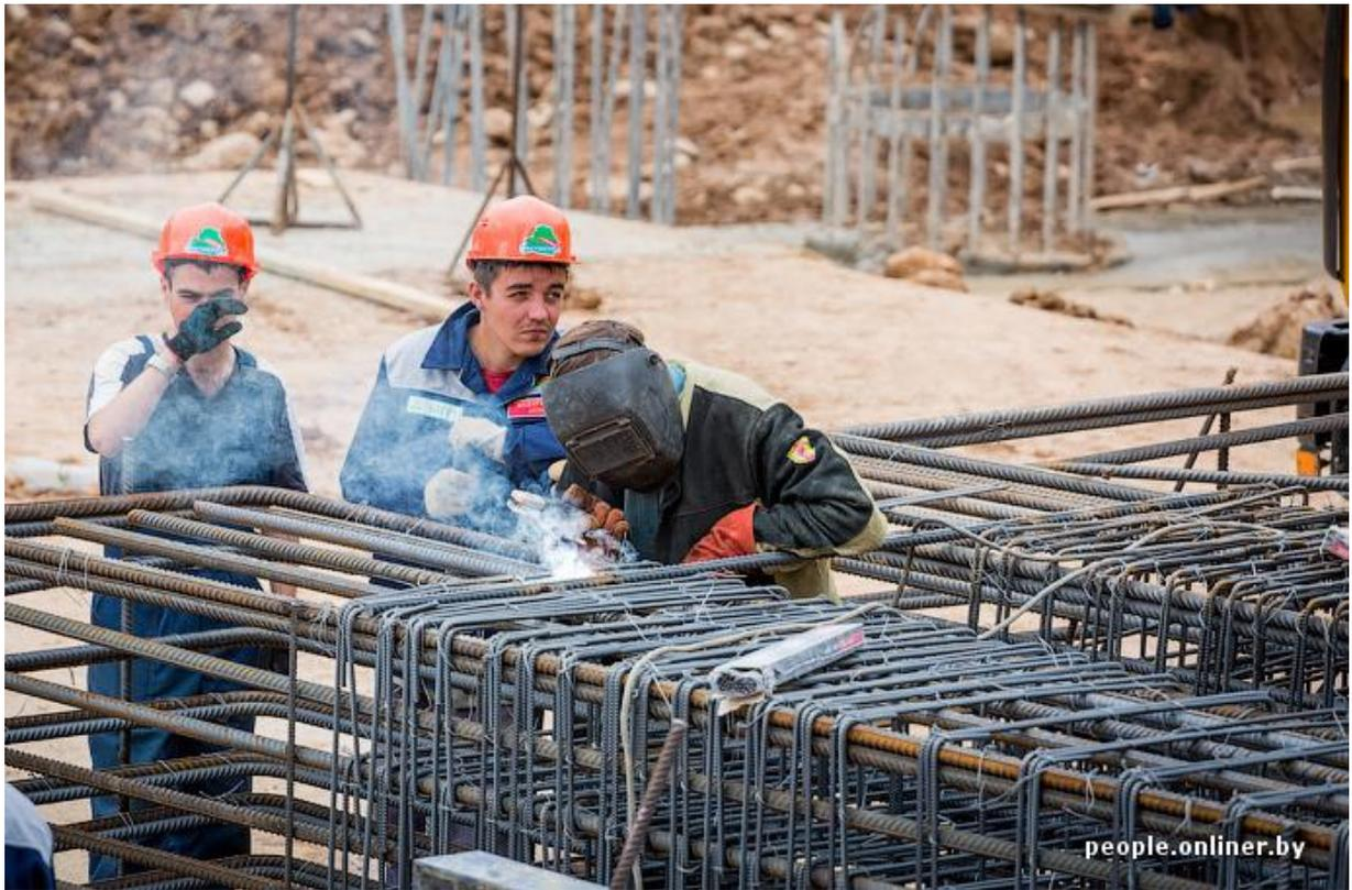
Рисунок. Изготовление каркаса на строительной площадке
