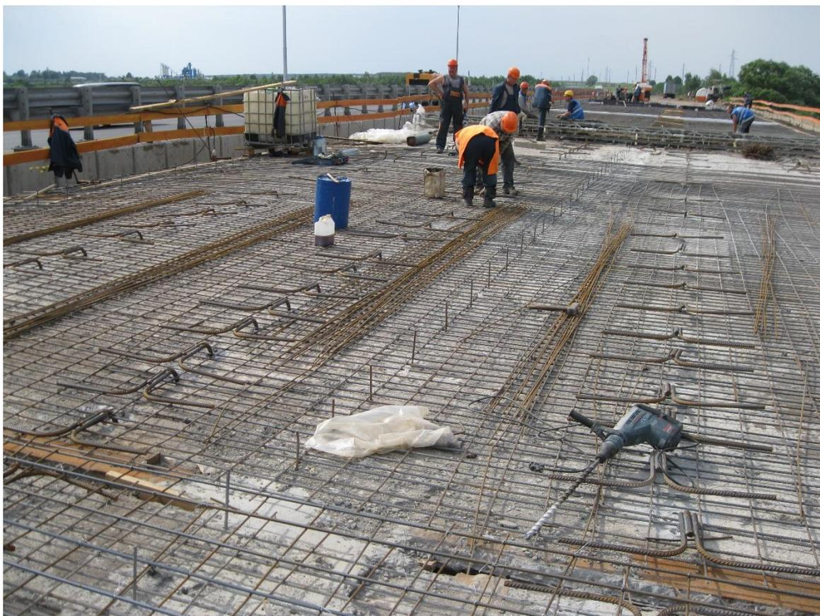
Рисунок. Проведение арматурных работ на пролетном строении
