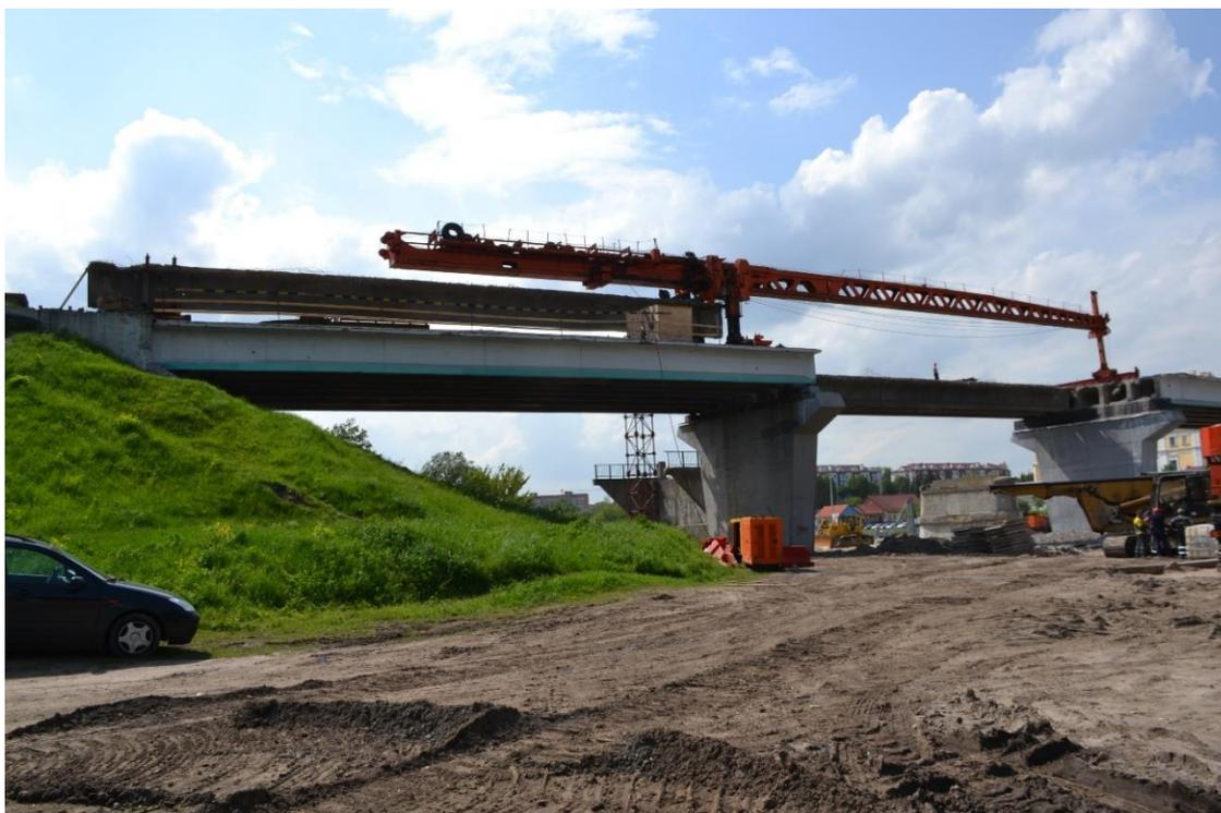
Рисунок. Подача балки пролетного строения для монтажа краном КШМ-63
