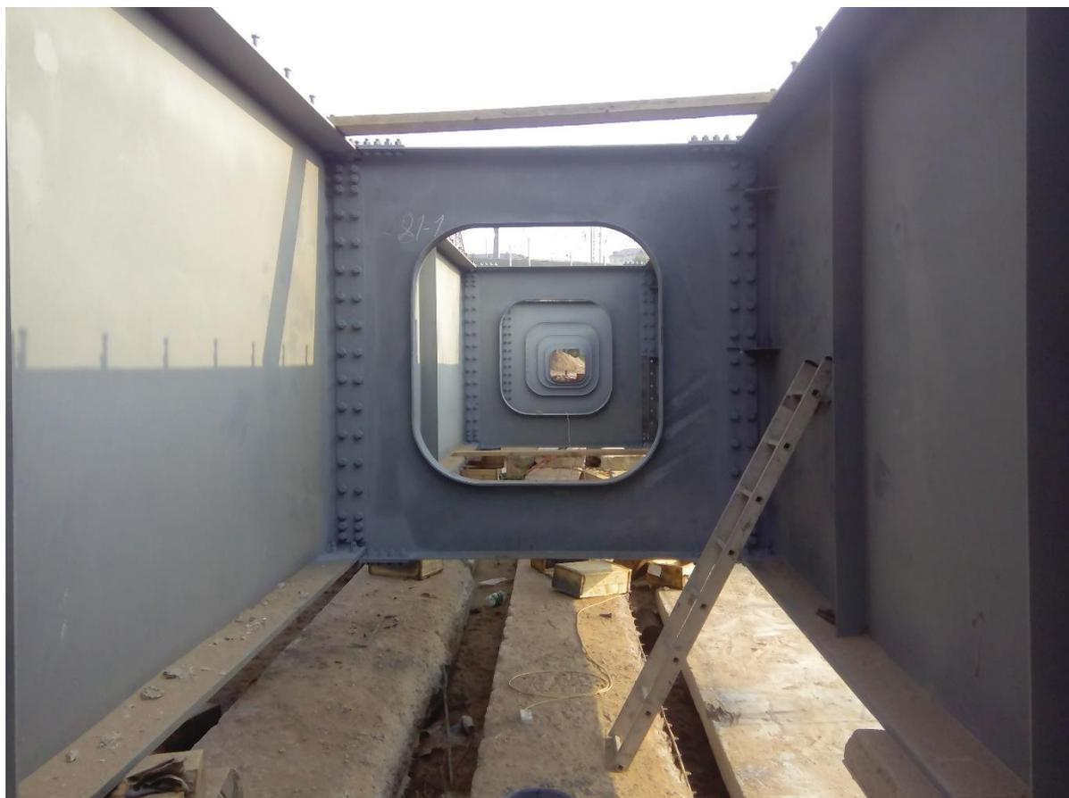
Рисунок. Подготовка пролетного строения к надвижке
