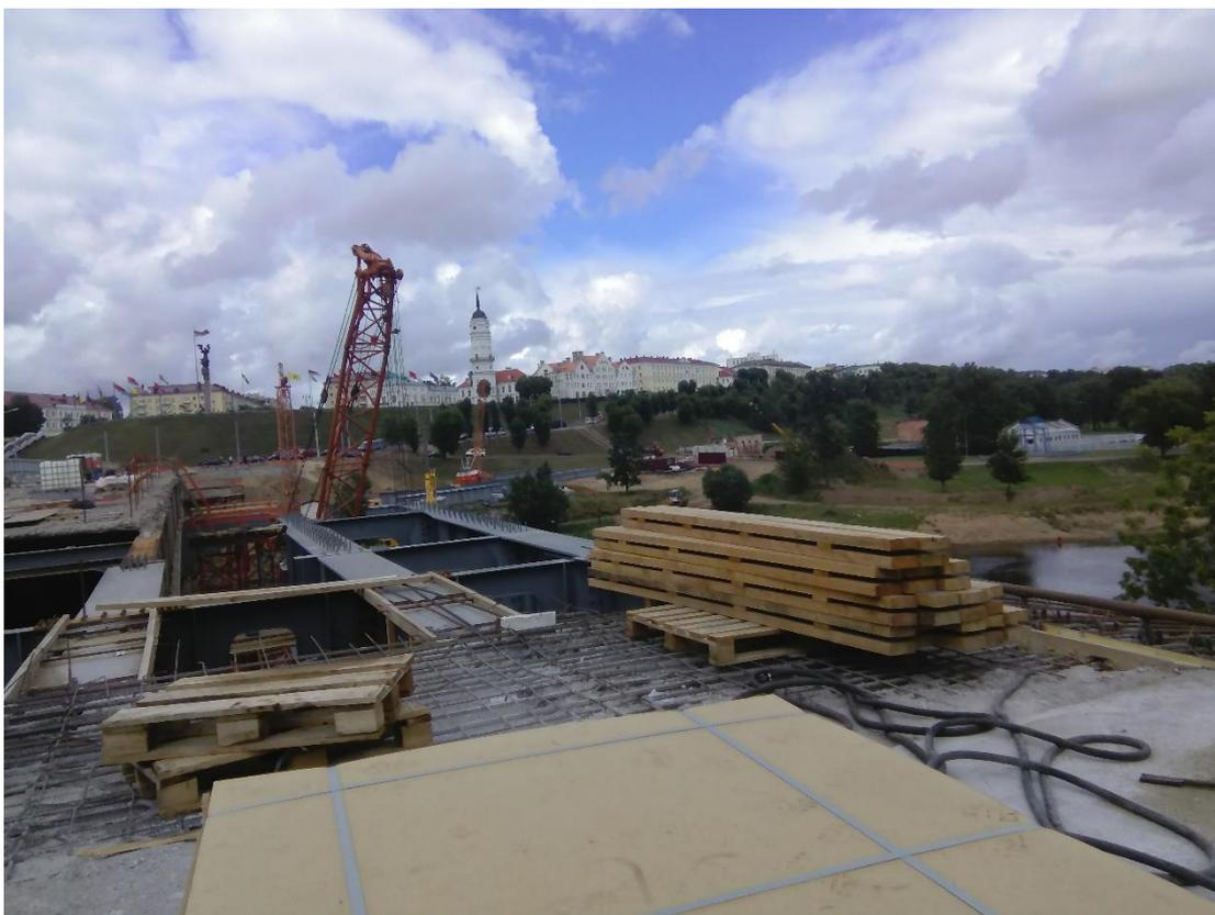
Рисунок. Склади́рование пиломатериала на пролетном строении
