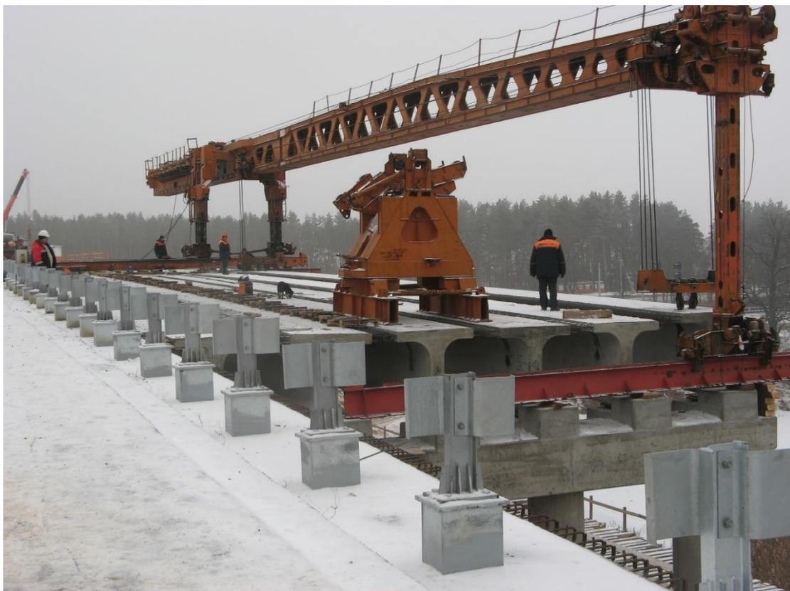
Рисунок. Монтаж балок пролетных строений краном КШМ-63
