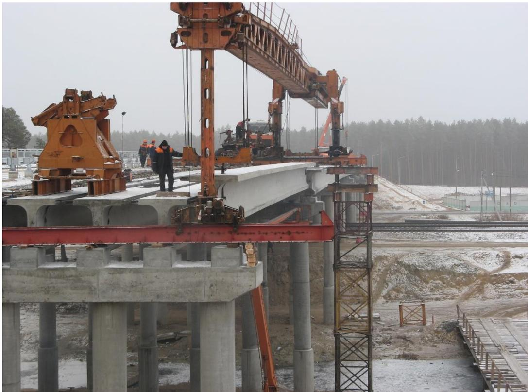
Рисунок. Монтаж балки пролетного строения краном КШМ-63
