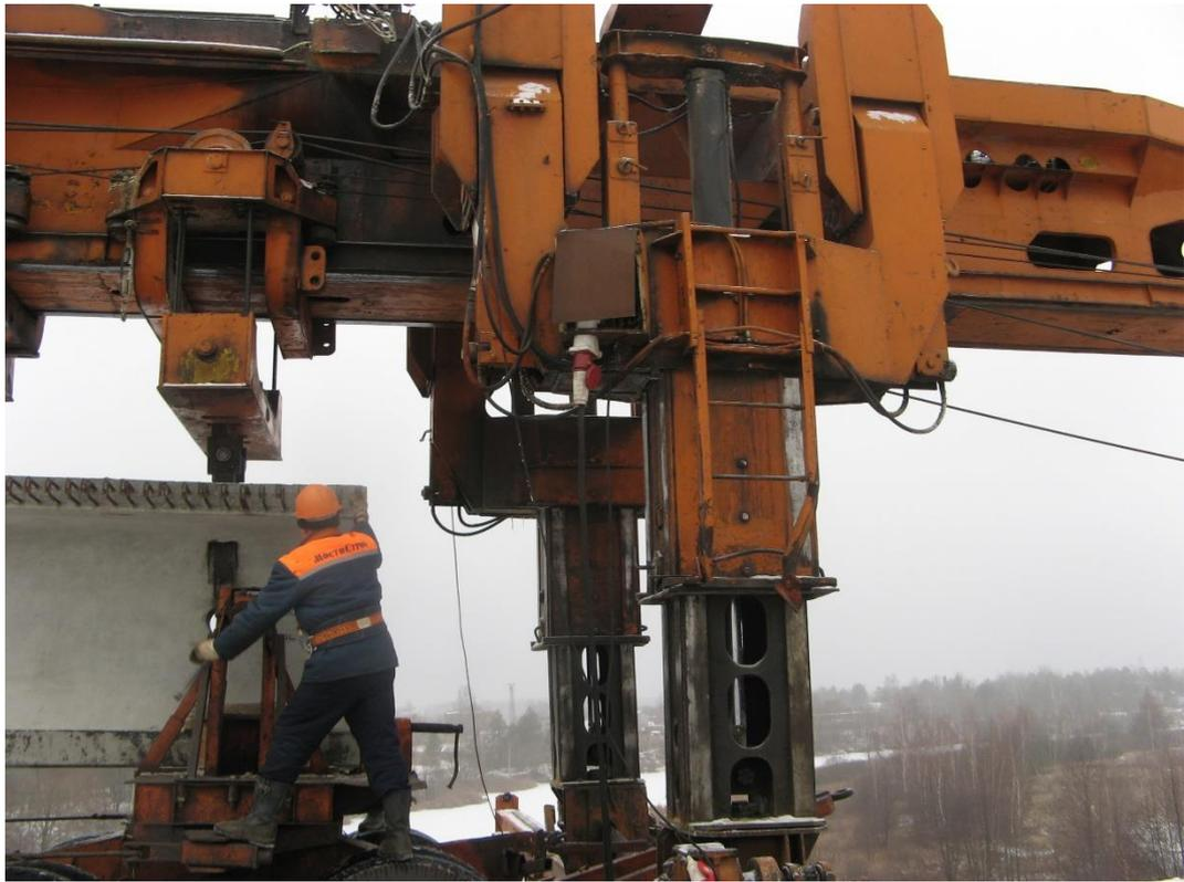
Рисунок. Крепление балки к грузовой тележке крана
