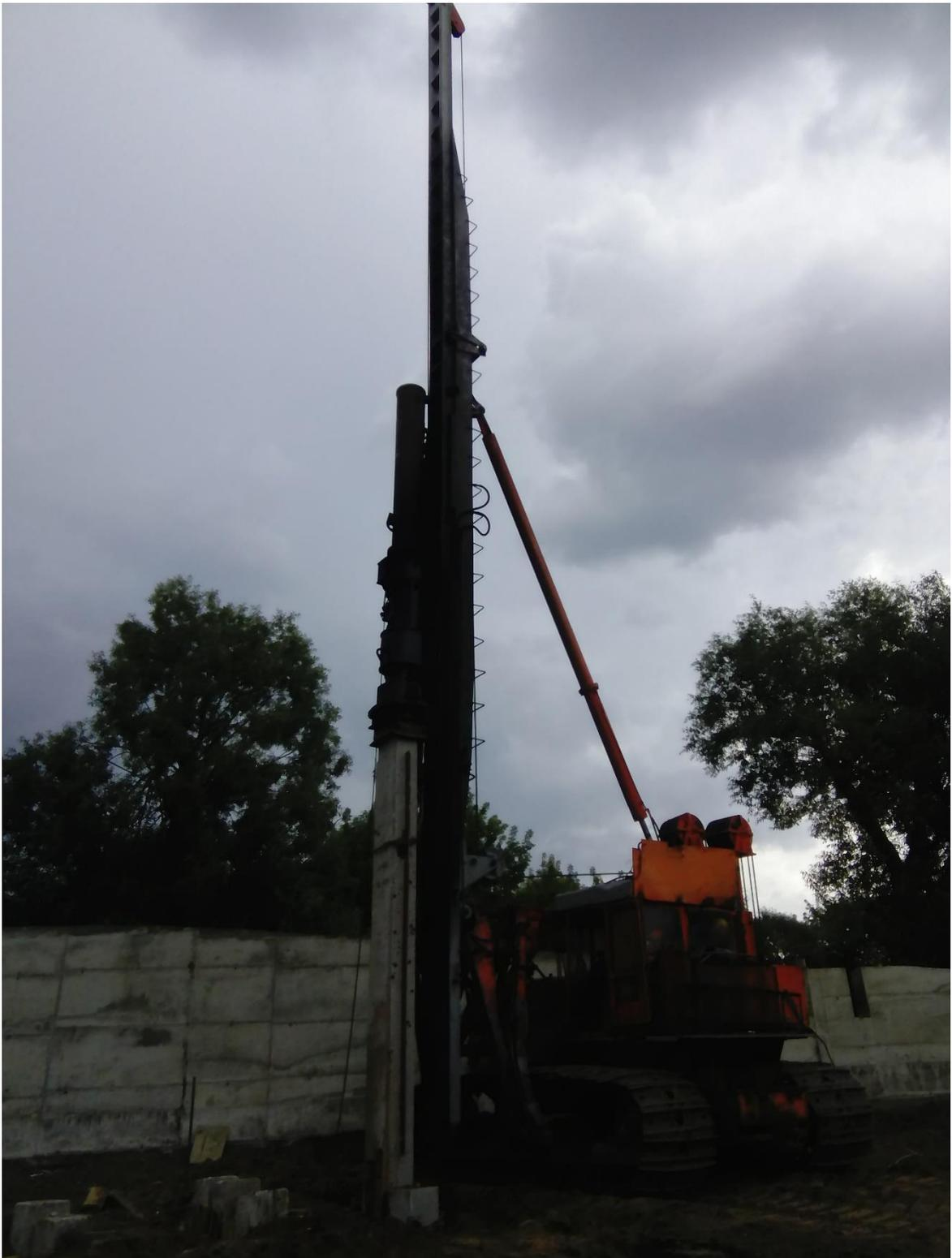
Рисунок. Погружение свай с использованием навесного оборудования
