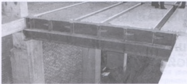
Рис. 7. Сталежелезобетонное перекрытие в г. Шклове (2-я очередь)
