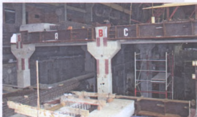
Рис. 6. Сталежелезобетонное перекрытие в г. Шклове (1-я очередь)
